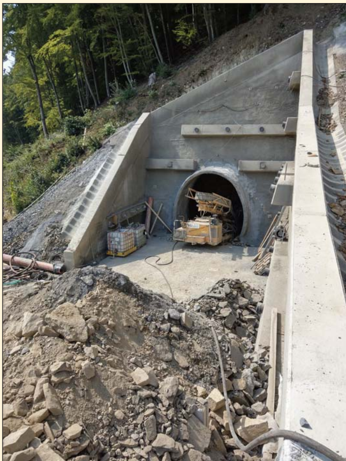
Obr. 4 Úniková štôľňa tunela Diel Fig. 4 Escape gallery of the Diel tunnel
