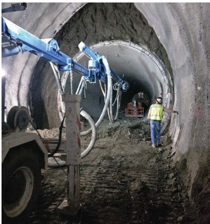
Obr. 16 Čelba levého dílčího výrubu Fig. 16 Left drift excavation face
