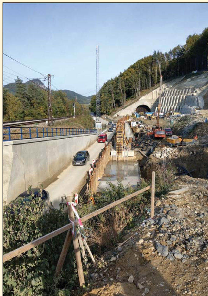
Obr. 7 Východný portál tunela Milochov Fig. 7 Eastern portal of the Milochov tunnel
