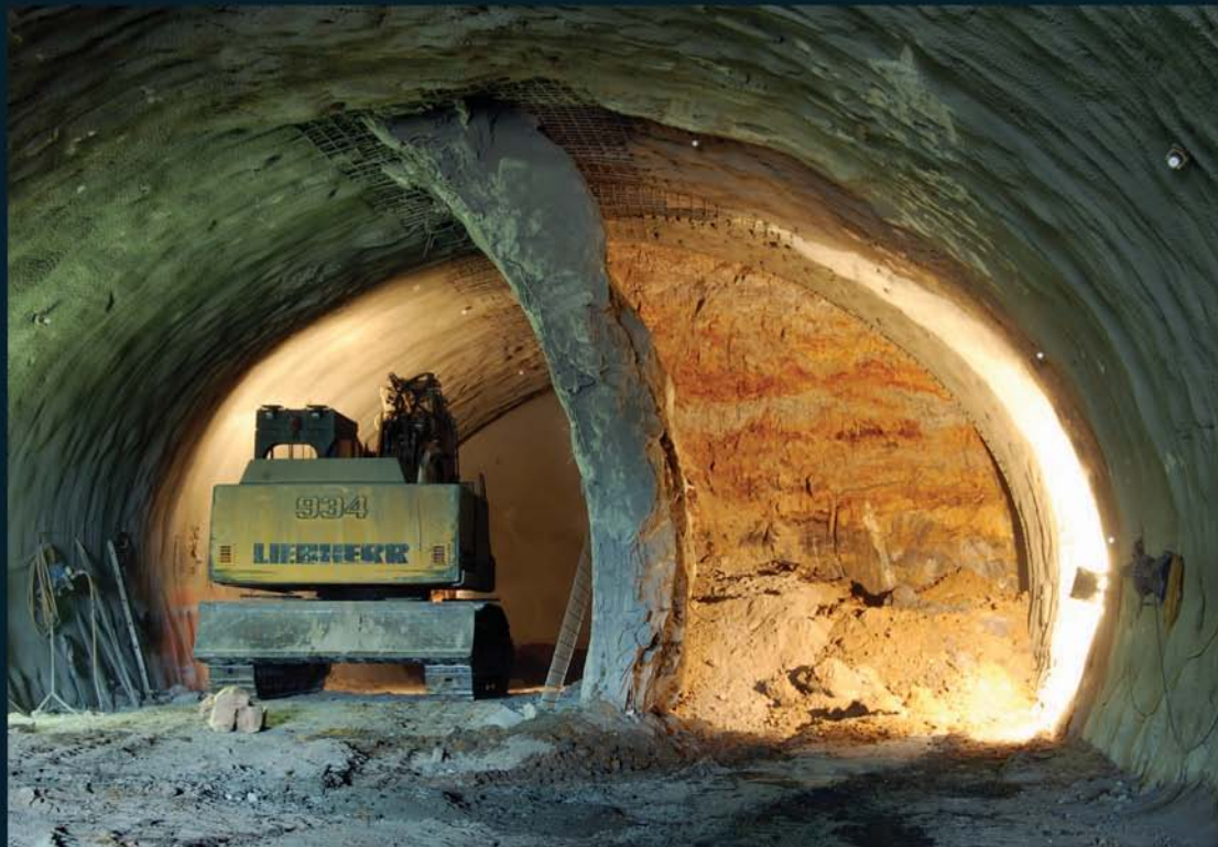
Trasa A pražského metra, stanice Nemocnice Motol - ražba dvoukolejného tunelu
