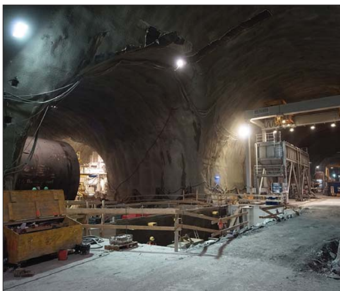
Obr. 8 Montážní komora tunelovacího stroje Fig. 8 Tunnel boring machine assembly chamber
