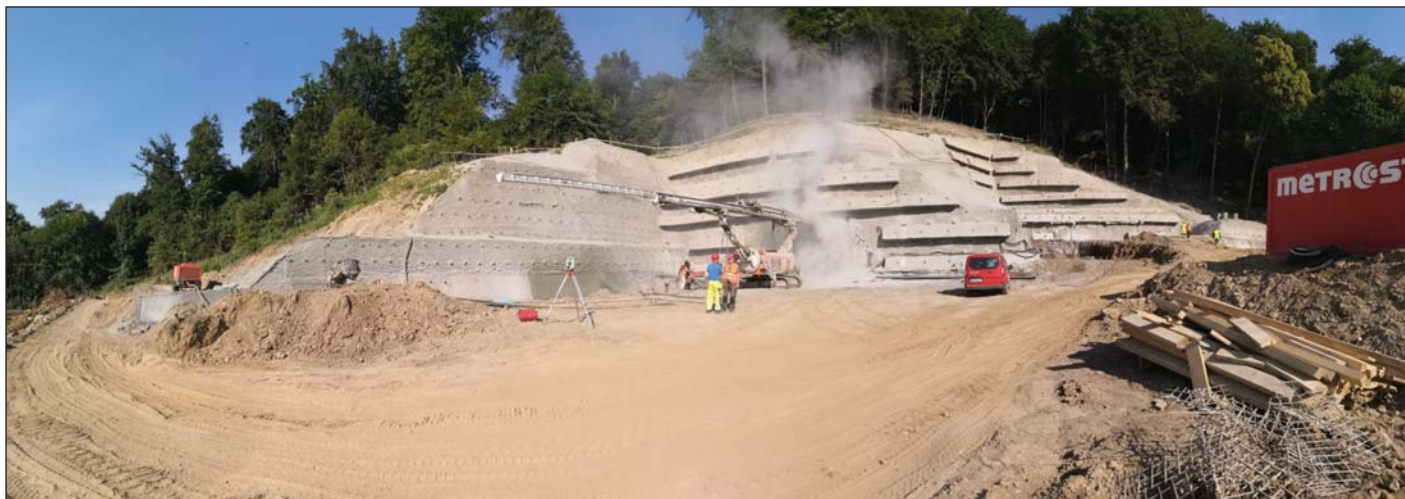
Obr. 1 Vrtanie mikropilótového dáždnika na východnom portáli Fig. 1 Drilling for canopy tube pre-support at the eastern portal
