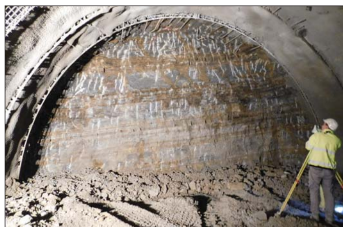
Obr. 5 Ražba severnej tunelovej rúry zo západného portálu, čelba tvorená ílovcovými a pieskovcovými vrstvami s pevnosťou R3, R4
