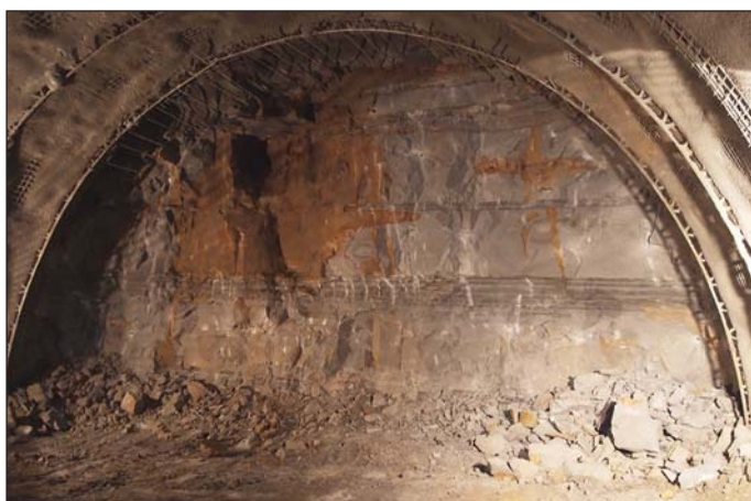
Obr. 4 Razenie južnej tunelovej rúry z východného portálu, čelba tvorená pieskovicami s tenkými vrstvami ílovcov
