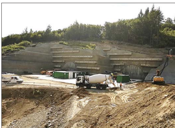
Obr. 2 Pohľad na západný portál pripravený na razenie oboch tunelových rúr Fig. 2 A view of the western portal prepared for excavation of both tunnel tubes
