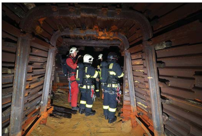
Obr. 5 Stávající přístupová štola Fig. 5 Existing access gallery
