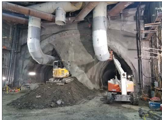
Obr. 10 Ražba bočních dílčích výrubů a výstavba rampy pro odstranění středního pilíře Fig. 10 Side drift excavation and development of ramp for pillar removal
