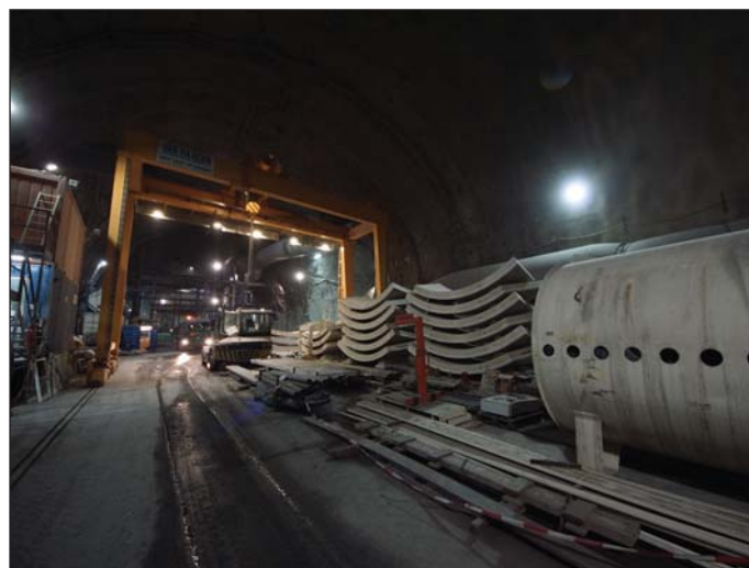
Obr. 7 Sklad tubingů v kaverně Fig. 7 Segment stock in a cavern
