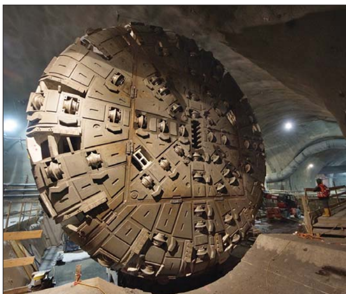
Obr. 10 Řezná hlava tunelovacího stroje Fig. 10 Cutterhead of the TBM
