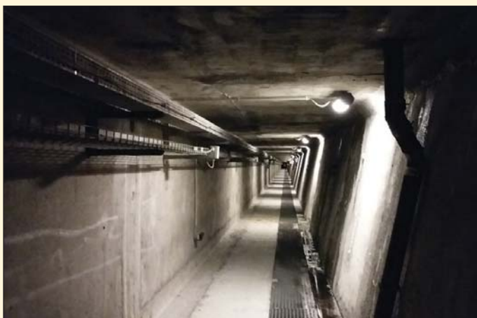
Obr. 3 Úniková štôlna z tunela Mont Blanc umiestnená pod vozovkou (11 611 m)
