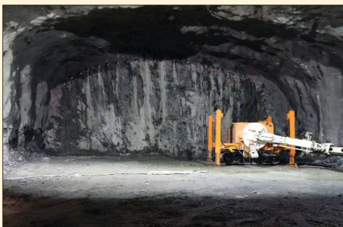
Obr. 4 Příklad čelby, v popředí vrtná souprava Casagrande PG185 (vzdálenost patek cca 6 m) pro provádění mikropilotového deštníku Fig. 4 Example of excavation face; in the foreground Casagrande PG185 drill rig (distance between footings ca 6m) for installation of canopy tube pre-support
