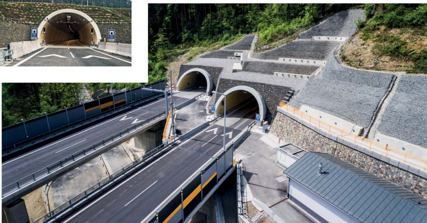
Tunel Považský Chlmec dálnice D3, úsek Žilina (Strážov) – Žilina (Brodno)
