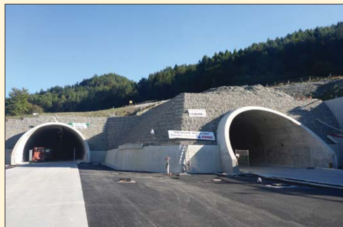
Obr. 2 Tunel Ovčiarisko Fig. 2 Ovčiarisko tunnel
