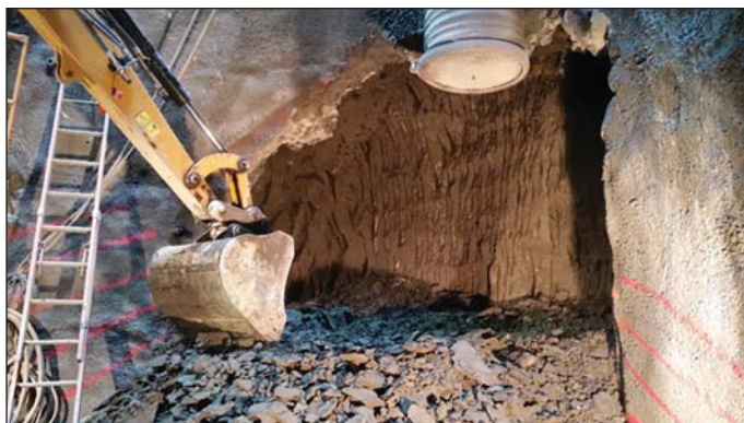
Obr. 6 Prorážka do štoly ze šachty zobrazující formaci Fernando Fig. 6 Adit breakout from shaft showing Fernando formation
