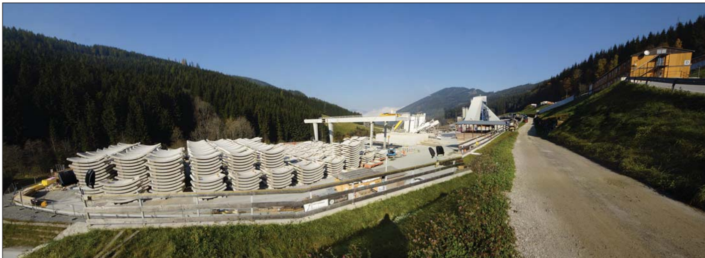
Obr. 1 Celkový pohled na zařízení staveniště Fig. 1 General view of the construction site
