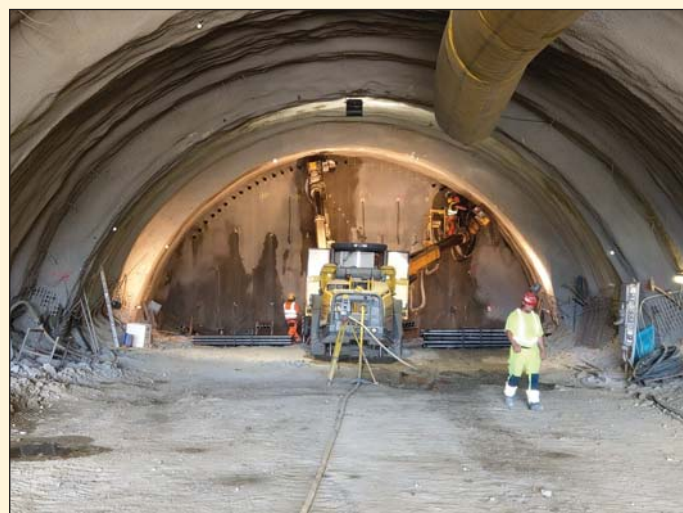
Obr. 6 Tunel Milochov – ražba z východného portálu Fig. 6 Milochov tunnel – excavation from the eastern portal
