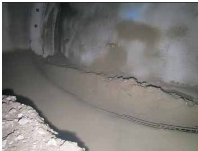
Obr. 11 Protiklenba budovaná v kalotě (falešné dno)
