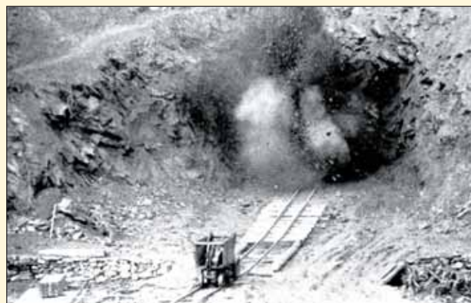
Obr. 1 První odpal na vodovodním přívaděči z Želivky do Prahy Fig. 1 First firing of charges in the Želivka water supply tunnel from Želivka to Prague
