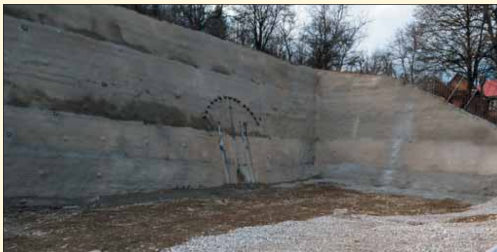
Obr. 8 Portál únikovej štôlne tunela Milochov Fig. 8 Milochov tunnel – escape gallery portal
