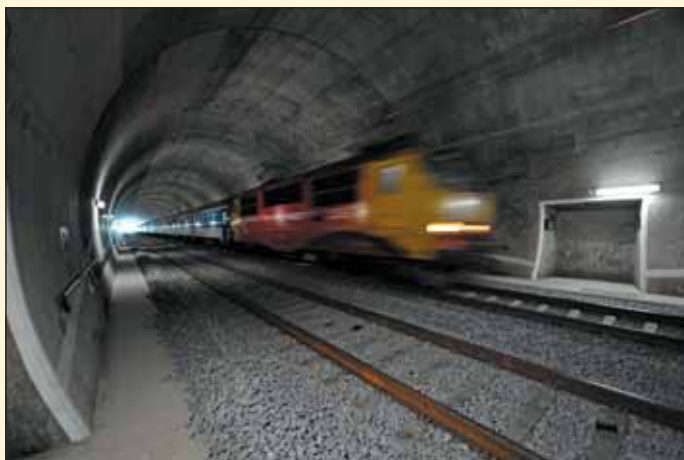
Obr. 6 Jablunkovský tunel, Optimalizace trati státní hranice SR – Mosty u Jablunkova – Bystřice nad Olší
