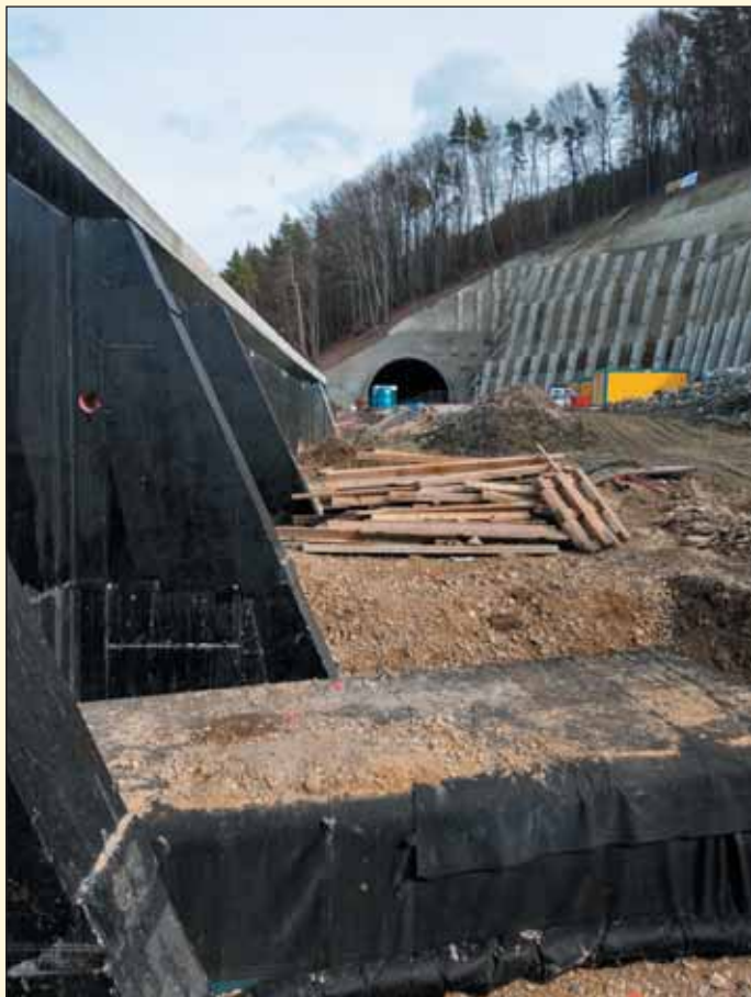
Obr. 7 Západný portál tunela Milochov Fig. 7 Milochov tunnel – western portal
