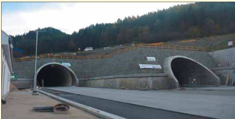
Obr. 2 Tunel Ovčiarisko – pohľad na tunelové rúry zo západného portálu Fig. 2 Ovciarisko tunnel – tunnel tubes viewed from the western portal
