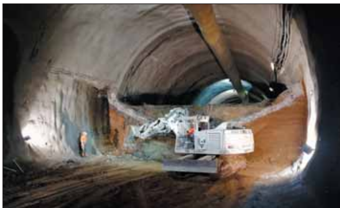
Fig. 3 Dobírání opěří a dna ve třídě VT Vc Fig. 3 Bench and bottom excavation, excavation support class VT Vc
