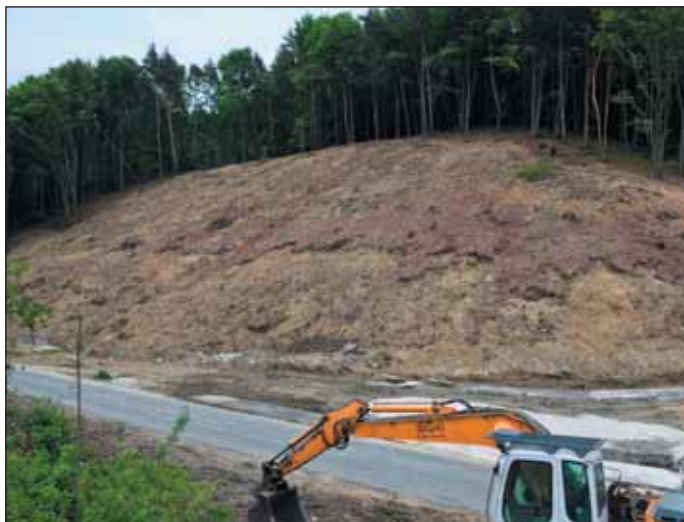
Obr. 1 Pohled na odlesněný svah budoucí stavební jámy západního portálu Fig. 1 A view of the deforested slope of the future construction pit for the western portal
