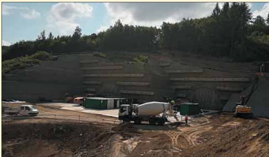
Obr. 4 Tunel Prešov – západný portál Fig. 4 Presov tunnel – western portal
