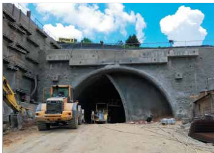
Obr. 11 Zahájení ražby ve třídě VI s vertikálně členěnou kalotou
