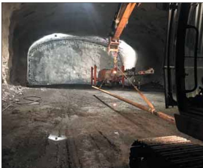
Obr. 8 Vrtání mikropilotového deštníku v tunelu hlavní trasy HT201 Fig. 8 Drilling for pipe roof umbrella in main-route tunnel HT201
