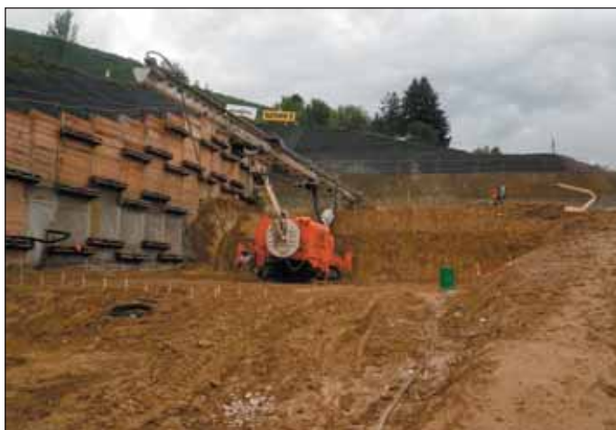
Obr. 5 Realizace tryskové injektáže Fig. 5 Realisation of jet grouting
