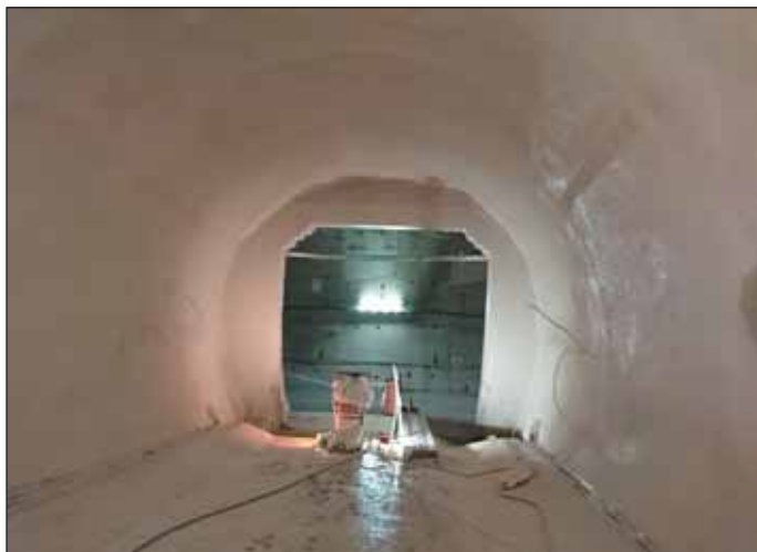
Obr. 5 Realizace stříkané izolace
