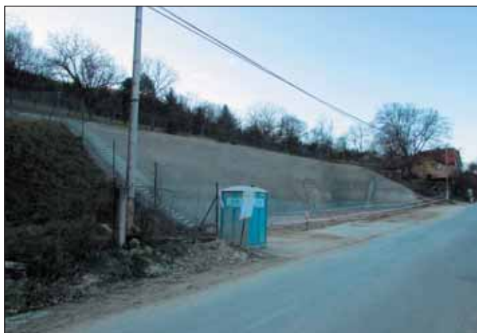
Obr. 7 Dokončená stavební jáma pro únikovou štolu Fig. 7 Completed construction pit for the escape gallery
