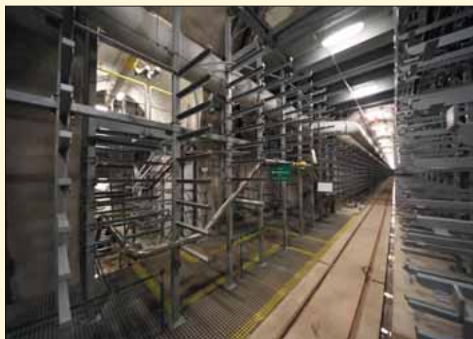
Obr. 1 Kolektor Hlávkův most
