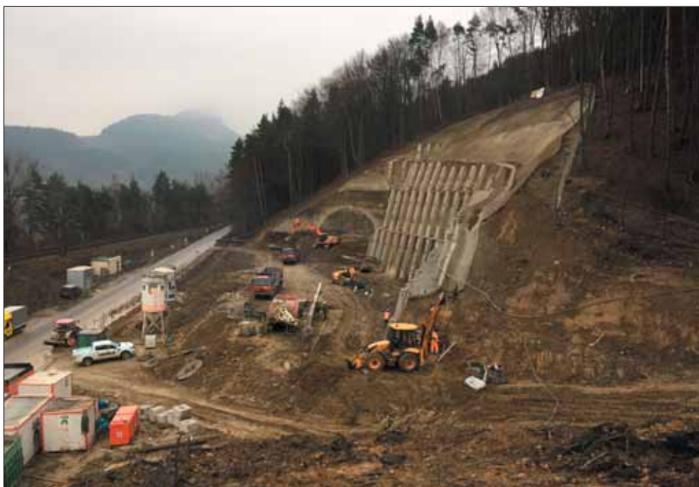
Obr. 2 Výstavba západního portálu Fig. 2 Construction of the western portal
