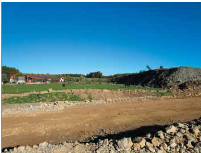
Obr. 5a Oblast deponie v průběhu výstavby Fig. 5a Area of the stockpile during the construction
