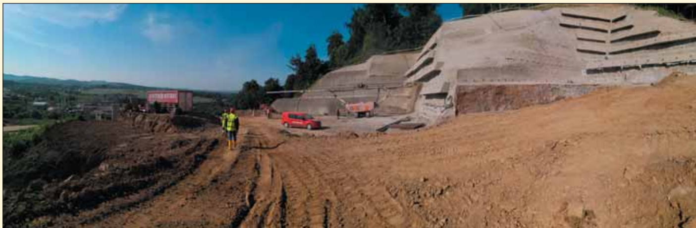
Obr. 3 Tunel Prešov – východný portál Fig. 3 Presov tunnel – eastern portal
