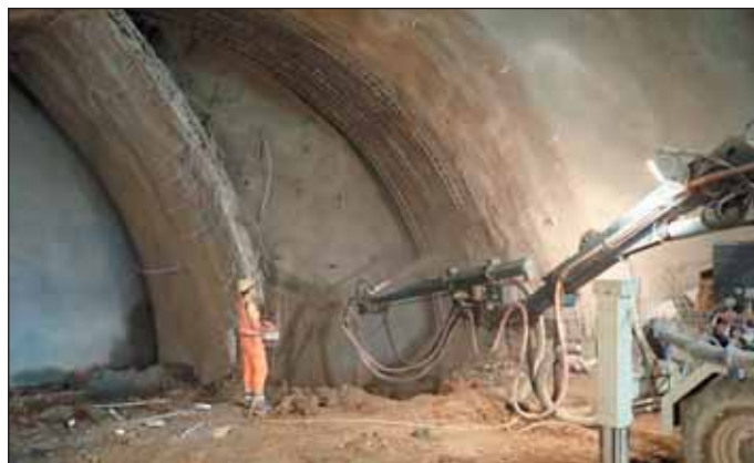
Fig. 4 Ražba s členěnou kalotou ve třídě VT VI Fig. 4 Sequential excavation of top heading, excavation support class VT VI
