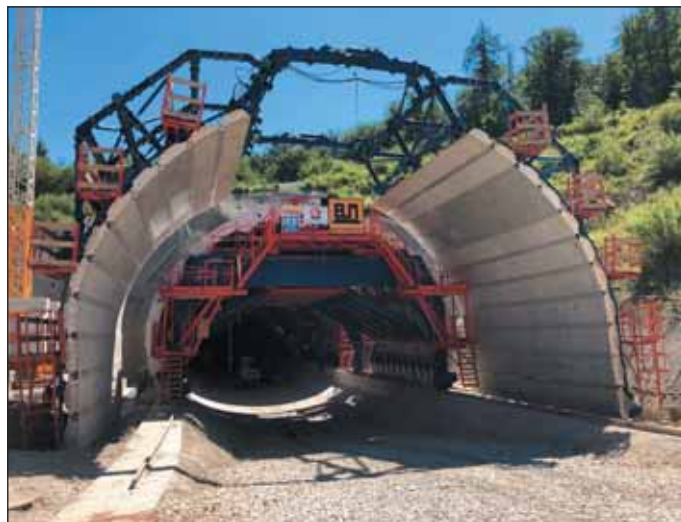
Obr. 19 Forma pro betonáž klenby s pojízdným bedněním pro betonáže v hloubeném úseku
