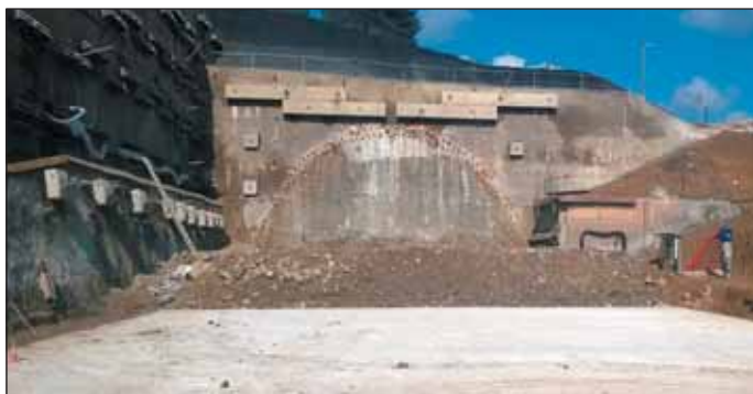
Obr. 10 Stěna východního portálu dle doplněné projektové dokumentace
