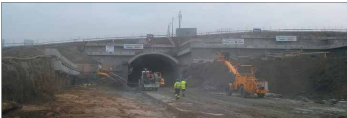
Obr. 2 Příprava západního portálu
