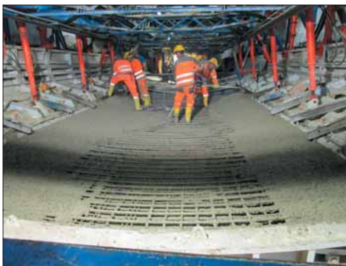
Obr. 18a Forma pro betonáž protiklenby
