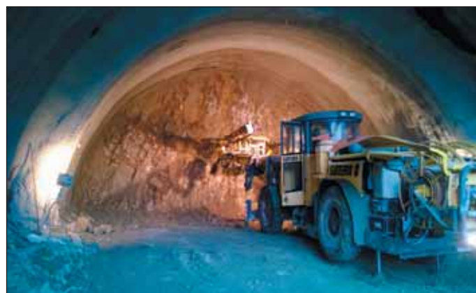
Obr. 8 Technologická třída výrubu Vb, vrtání čelbových kotev Fig. 8 Excavation support class Vb, drilling into advance core for anchors
