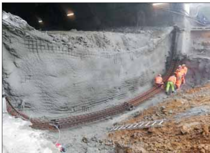
Obr. 12 Uzavírání celého profilu díla pomocí příhradových rámu Fig. 12 Closing the whole excavated tunnel profile using lattice girders
