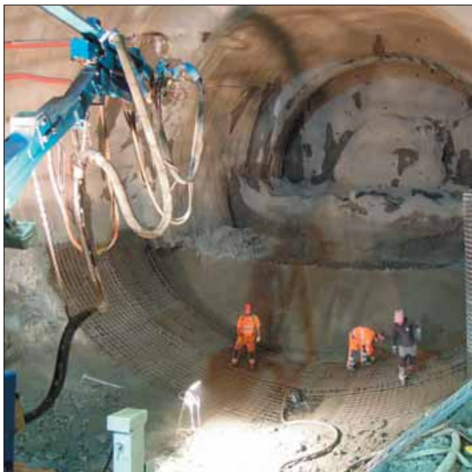
Obr. 6 Vrtání mikropilotových dešťníků a čelbových kotev
