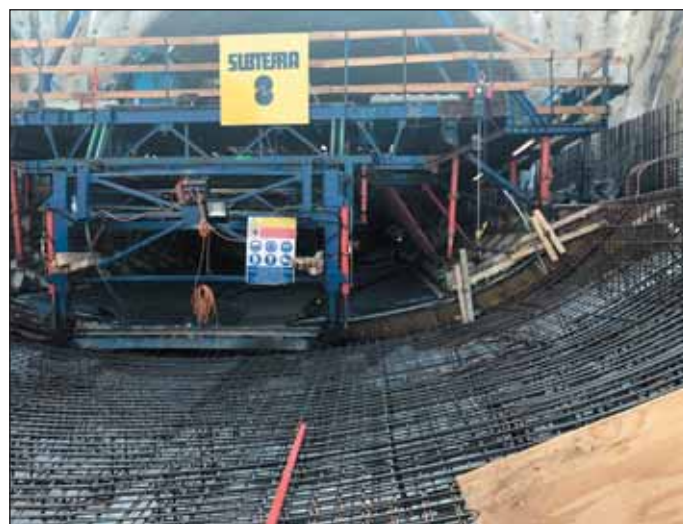
Obr. 18b Forma pro betonáž protiklenby
