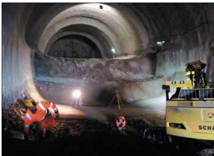
Obr. 9 Dobírání opěří a protiklenby ve třídě Vb
