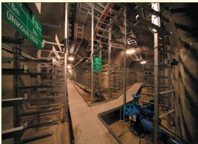
Obr. 4 Kolektor Centrum I.A, Vodičkova, Praha Fig. 4 Centrum I.A utility tunnel, Vodičkova Street, Prague
