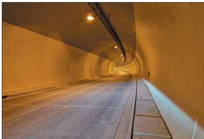
Obr. 4 Južná tunelová rúra – sekundárne ostenie
