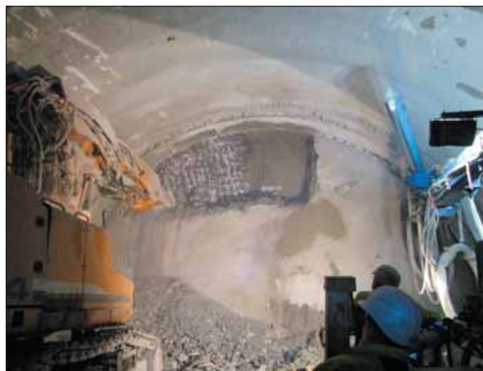
Obr. 12b Otevírání a zajišťování čelby po částech při zhoršení horninového prostředí (severní trouba)
