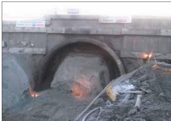
Obr. 5 Zahájení ražby JTT ze západního portálu
