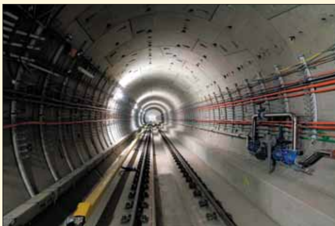
Obr. 8 Technologie při výstavbě prodloužení metra V.A Dejvická – Motol, Praha
