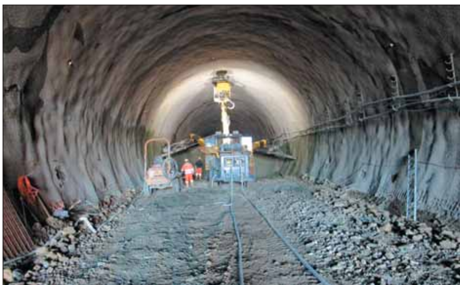
Obr. 13 Ražba lávky severní trouby
