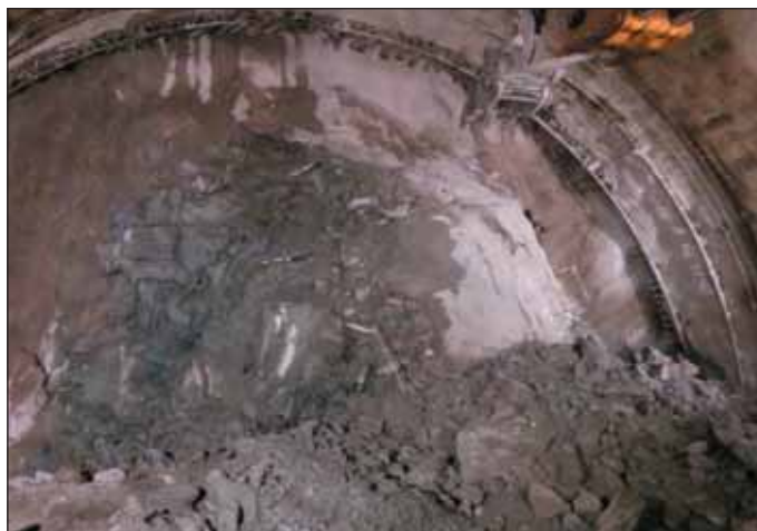
Obr. 2 Odťahba pritlačovacieho klina čelby
