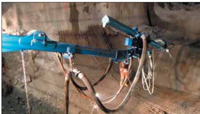
Obr. 3 Uzavírání celého profilu tunelu Fig. 3 Closing of the whole tunnel profile
