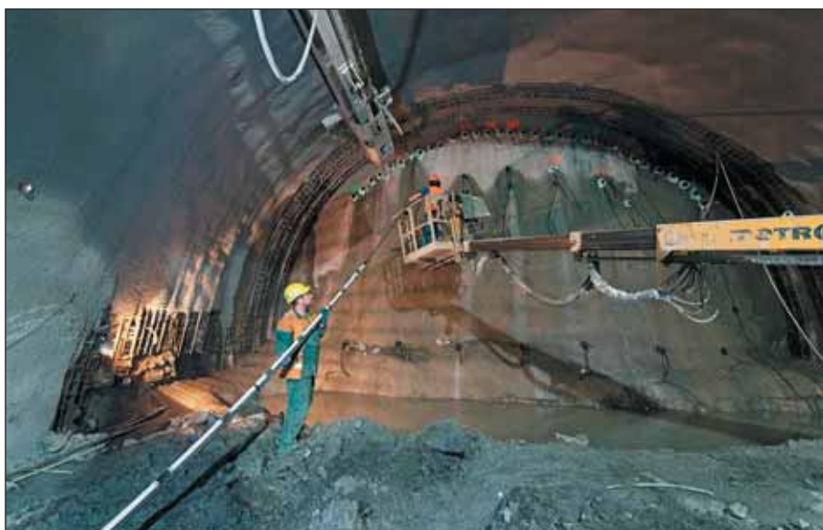
Obr. 7 Úprava tvaru příčného profilu
