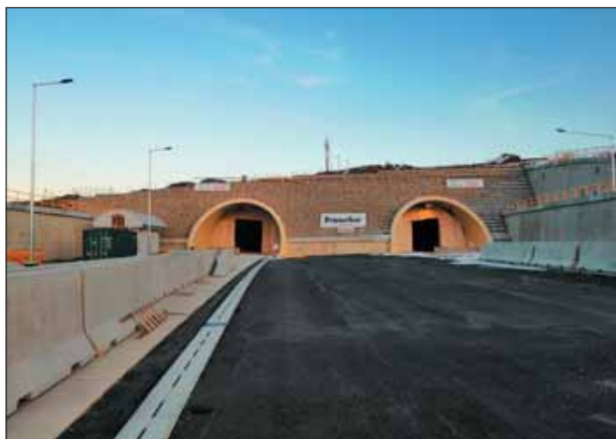
Obr. 6 Pohľad na západný portál tunela Žilina
