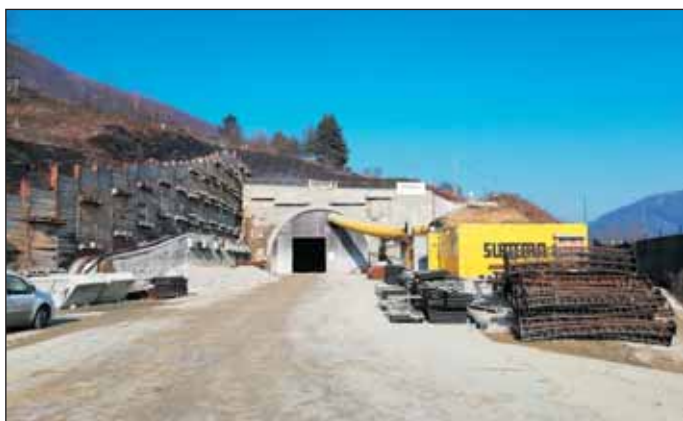
Fig. 1 Pohled na východní portál tunelu Milochove Fig. 1 A view of the eastern portal of Milochove tunnel
