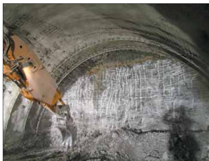
Obr. 9 Čelba kaloty – geologický profil severní trouba
