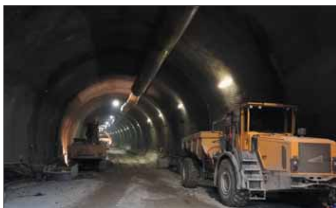
Fig. 6 Pohled do vyražené části tunelu Fig. 6 A view down the excavated part of the tunnel
