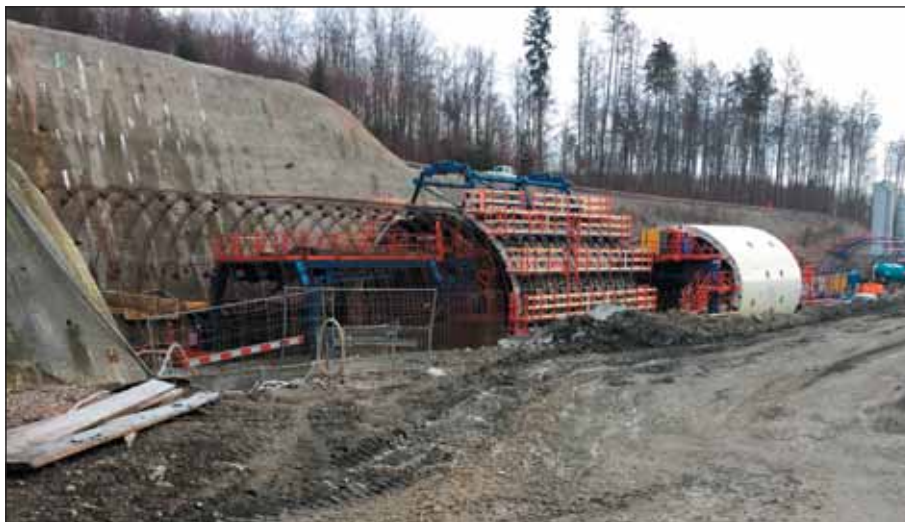
Obr. 17 Samonosná výztuž, hloubený úsek, severní tunelová trouba
