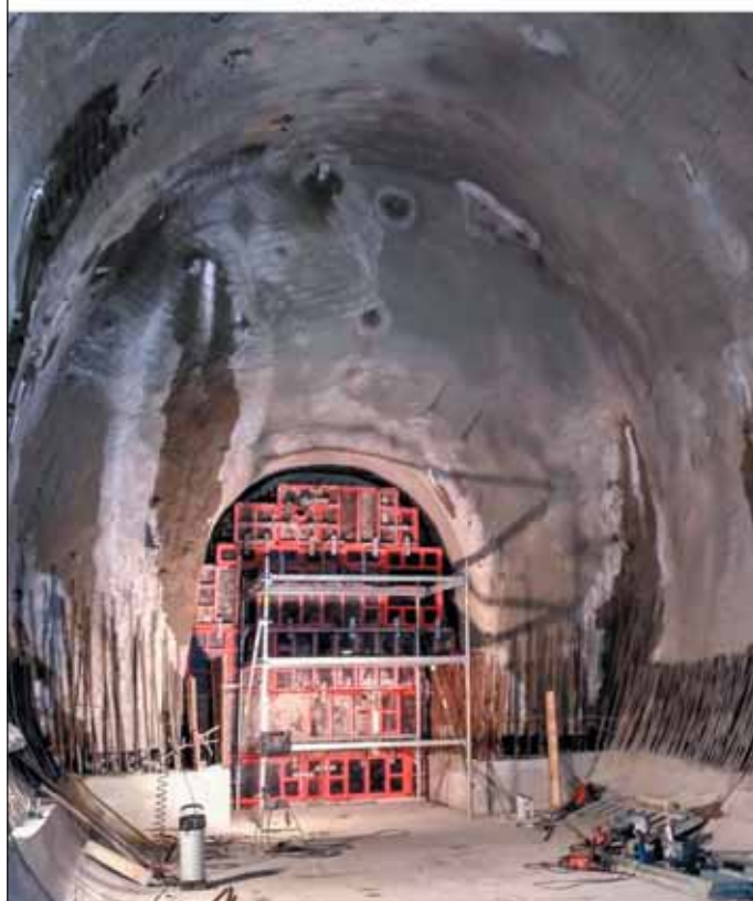
Obr. 10 Praha kolektor Hlávkaův most 73,3 m 2 , prvků matice 1251, počet neznámých 143
