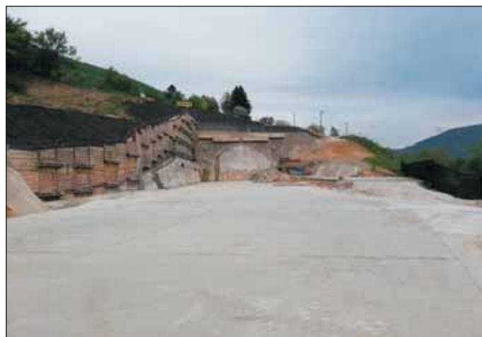
Obr. 6 Dokončený východní portál pro ražbu Fig. 6 Completed eastern portal prepared for tunnel excavation
