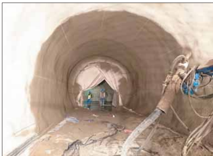
Obr. 6 Realizace stříkaného drátkobetonu
