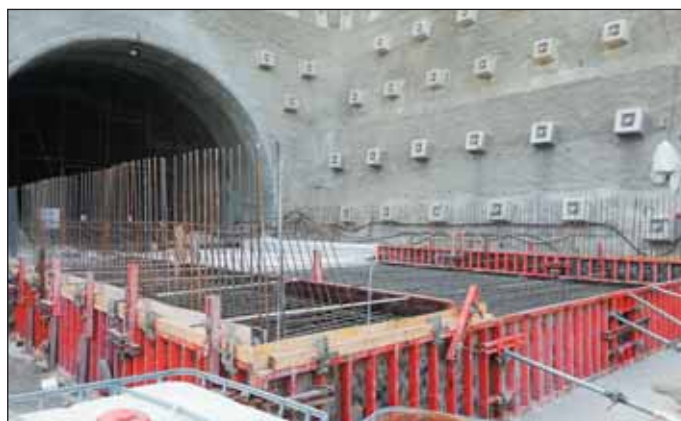
Fig. 2 Realizace základové desky hloubeného úseku – západní portál tunelu Fig. 2 Realisation of base slab in the cut-and-cover section –western portal of the tunnel
