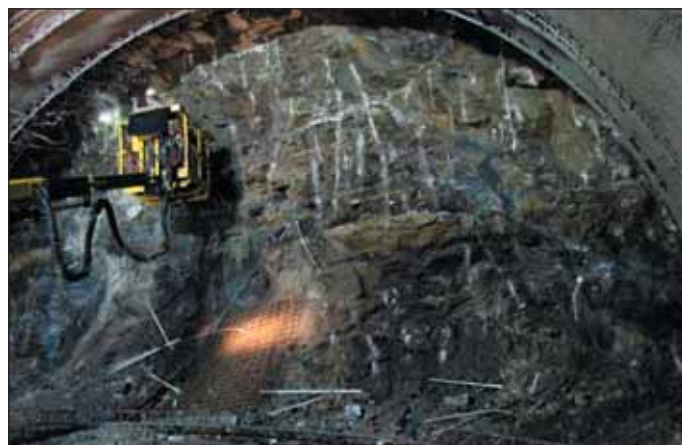
Obr. 6 Pohled na čelbu ve staničení 127,3 TM
