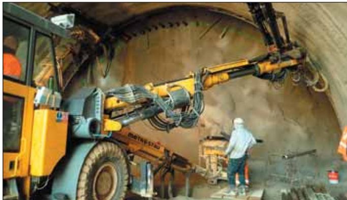
Obr. 3 Instalace mikropilotového deštníku v náročných IG poměrech v počátku ražby tunelu Deboreč (únor 2019) Fig. 3 Installation of the canopy tube pre-support in complicated EG conditions at the beginning of the Deboreč tunnel excavation (February 2019)
