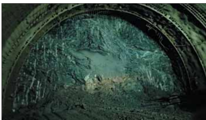
Obr. 5 Čelba tunelu Deboreč v provrásněných pararulách (srpen 2019) Fig. 5 Deboreč tunnel excavation face in folded paragneiss (August 2019)
