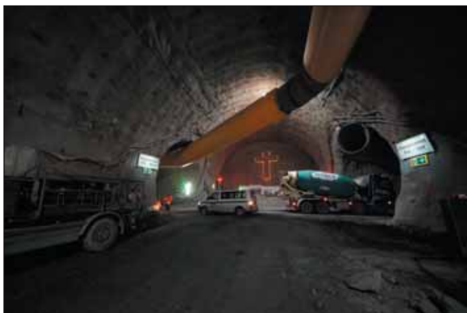
Obr. 3 Směr Innsbruck 25 km – Směr Franzensfeste 32 km Fig. 3 Innsbruck direction 25km – Franzensfeste direction 32km
