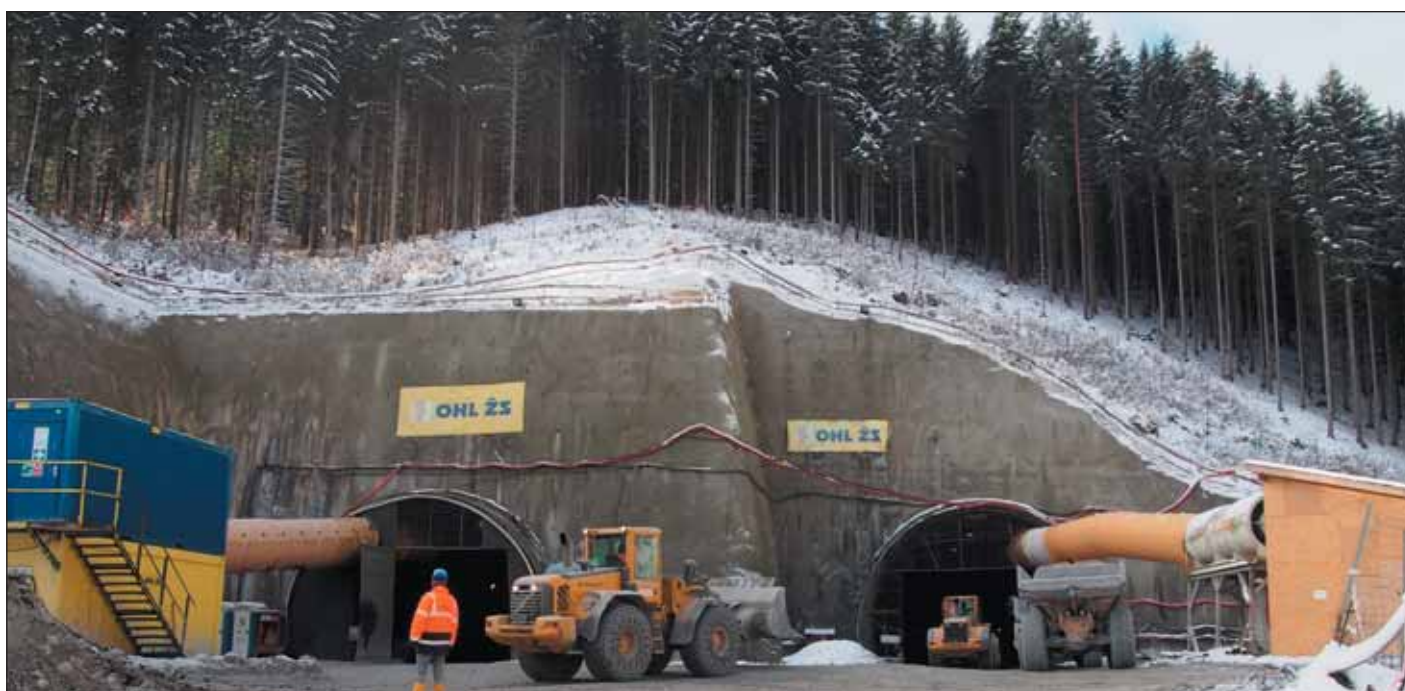
Obr. 7 Východný portál Fig. 7 Eastern portal
