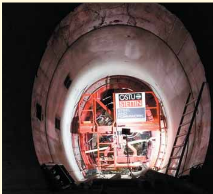
Obr. 7 Tunel Diel – sekundárne ostenie v únikovej štôlni Fig. 7 Diel tunnel – secondary lining in the escape gallery
