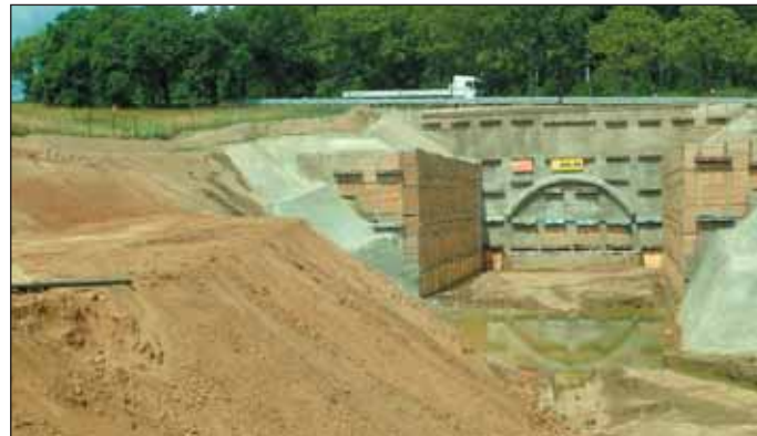
Obr. 4 Pohled na zajištěnou jámu vjezdového portálu tunelu Deboreč (červen 2019) Fig. 4 A view of the stabilised construction pit for the entrance portal of the Deboreč tunnel (June 2019)
