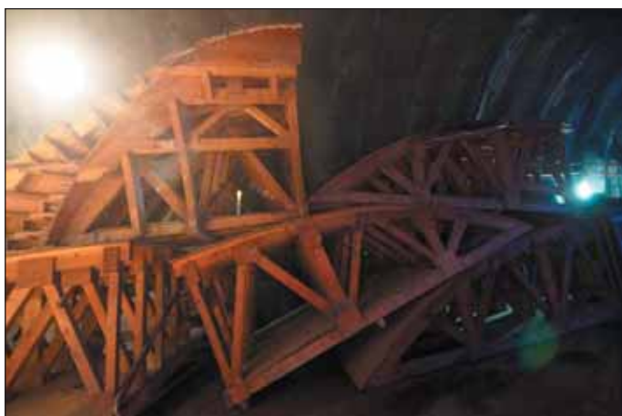
Obr. 1 Bednění atypických profilů Fig. 1 Formwork for atypical profiles
