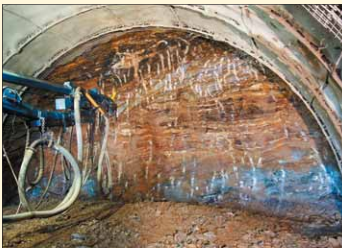
Obr. 4 Čelba kaloty tunelu Mezno v TM 39
