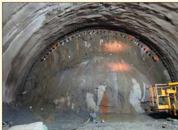
Obr. 5 Mikropilotový deštník vrtaný z profilu tunelu Deboreč v TM 341
