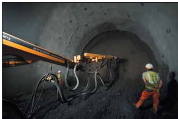
Obr. 2 Stabilizace čelby jednokolejného tunelu stříkaným betonem Fig. 2 Stabilisation of excavation face of single-track tunnel with shotcrete
