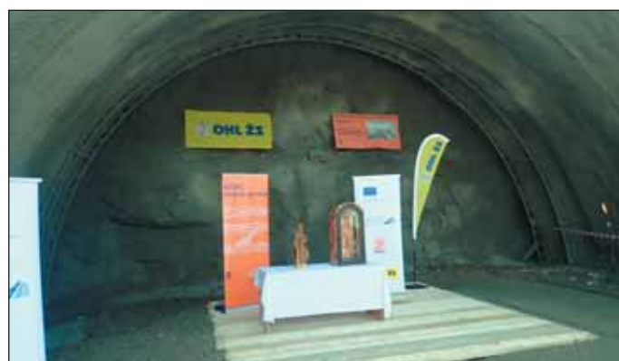
Obr. 6 Slavnostní zahájení ražeb tunelu Mežno (srpen 2019) Fig. 6 Ceremonial commencement of excavation of the Mežno tunnel (August 2019)
