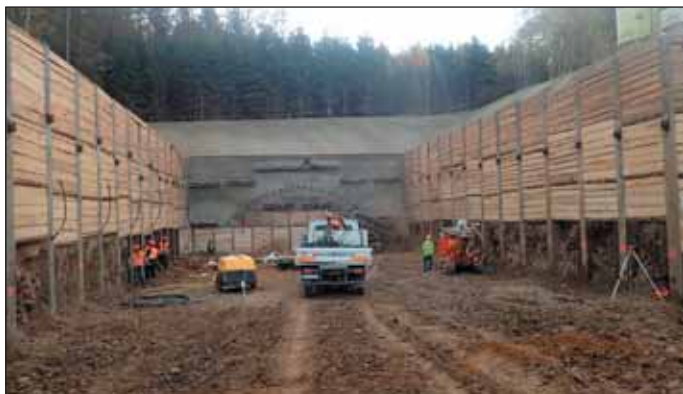
Obr. 1 Hloubení pažené jámy výjezdového portálu tunelu Deboreč (říjen 2018) Fig. 1 Excavation of braced construction pit for exit portal of the Deboreč tunnel (October 2018)
