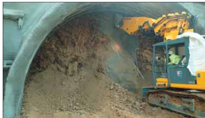
Obr. 2 První metry ražeb tunelu Deboreč z výjezdového portálu ve zvětralých pararulách (leden 2019) Fig. 2 Initial metres of excavation of the Deboreč tunnel from the exit portal through weathered paragneiss (January 2019)
