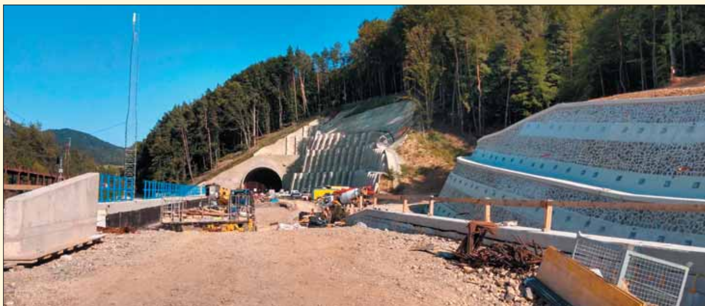
Obr. 8 Tunel Milochov – západný portál Fig. 8 Milochov tunnel – western portal
