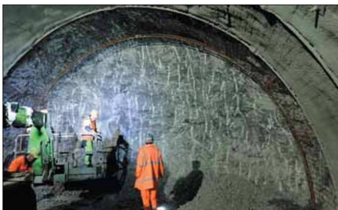
Obr. 9 Čelba kaloty v slienitých vápencoch Fig. 9 Top heading excavation face in marlaceous limestone
