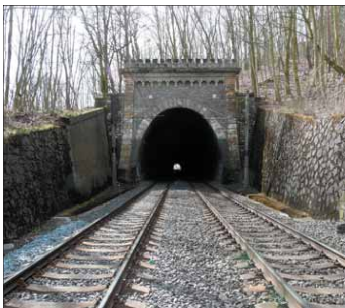
Obr. 2 Stávající severní portál tunelu č. III
