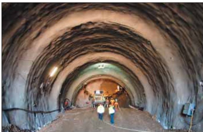
Obr. 5 Vrtání mikropilotového deštníku v tunelu
