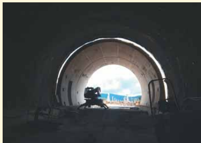
Obr. 6 Tunel Diel – hĺbený tunel na východnom portáli Fig. 6 Diel tunnel – cut-and-cover tunnel at the eastern portal
