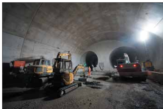
Obr. 4 Sekundární ostění kaverny před napojením na Inntaltunnel Fig. 4 Secondary lining of the cavern before the connection to Inntaltunnel
