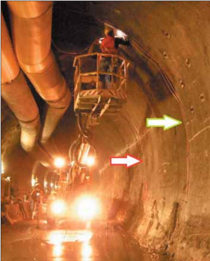
Obr. 3 Instalace měřicího kabelu BOTDA na primární ostění středního tunelu před stanicí Petřiny; červená šipka značí měřicí linii v příčném profilu, zelená vedení kabelu k optickému rozvaděči
