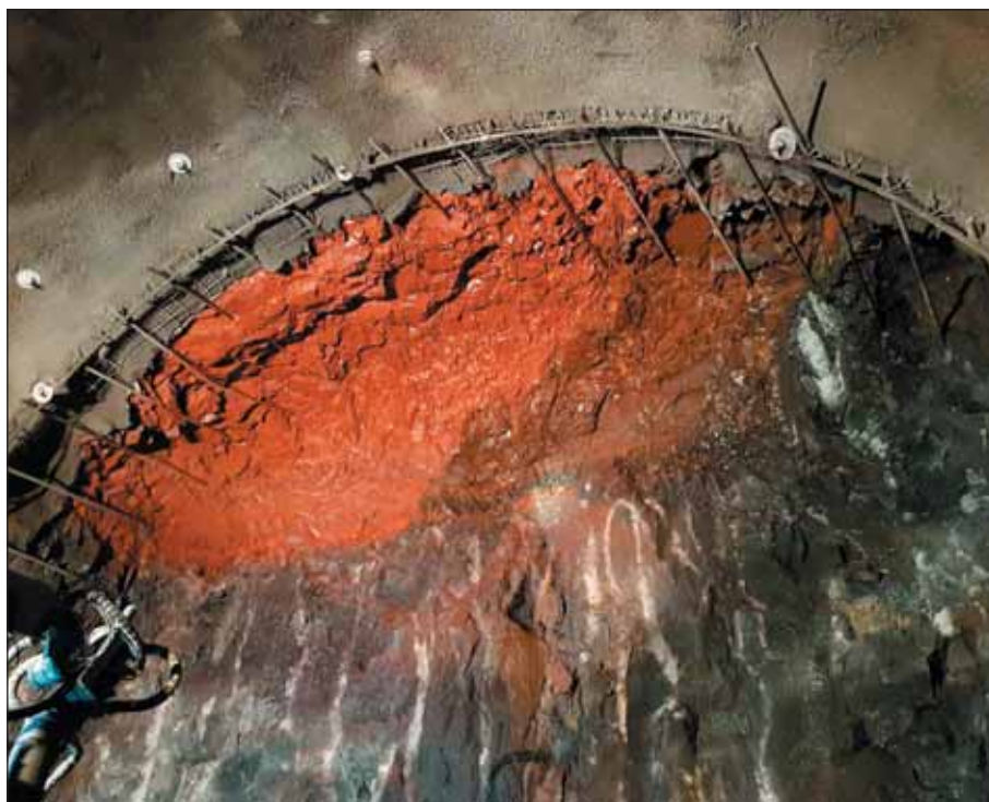
Obr. 3 Sedimentární vložka sestupuje od stropu Fig. 3 Sedimentary interlayer descending from the excavation roof
