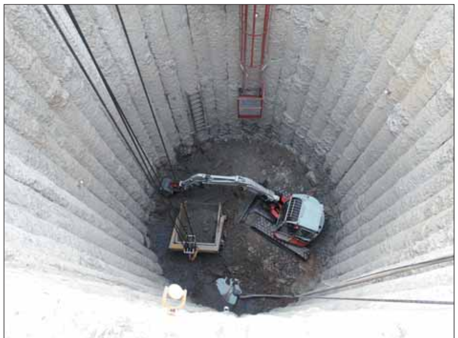
Obr. 3 Hloubení stavební šachty Fig. 3 Excavation of construction shaft
