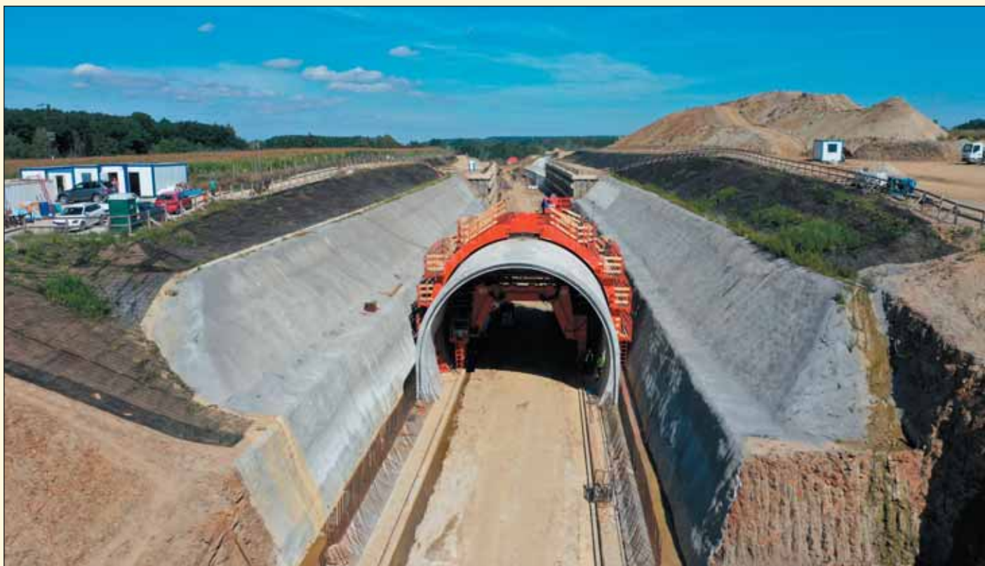
Obr. 6 Tunel Zvěrotice – celkový pohled
