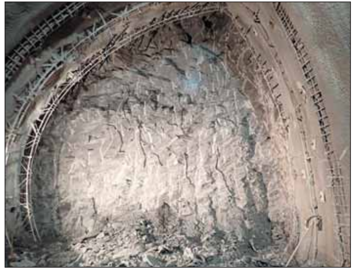
Obr. 8 Čelba štoly VO-OL v TM 135,5 zastihující zdravé břidlice královodvorského souvrství bez výrazného tektonického porušení Fig. 8 Excavation face of VO-OL gallery at TM 135.5 chainage encountering fresh Králův Dvůr Formation shale without marked tectonic faulting
