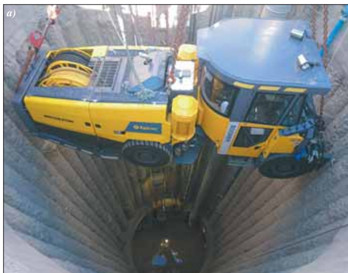
Obr. 9 Spouštění částečně demontovaného vrtacího vozu S2 (a) a jeho ramen (b) Fig. 9 Lowering of partially disassembled drill rig S2 (a) and its booms (b)
