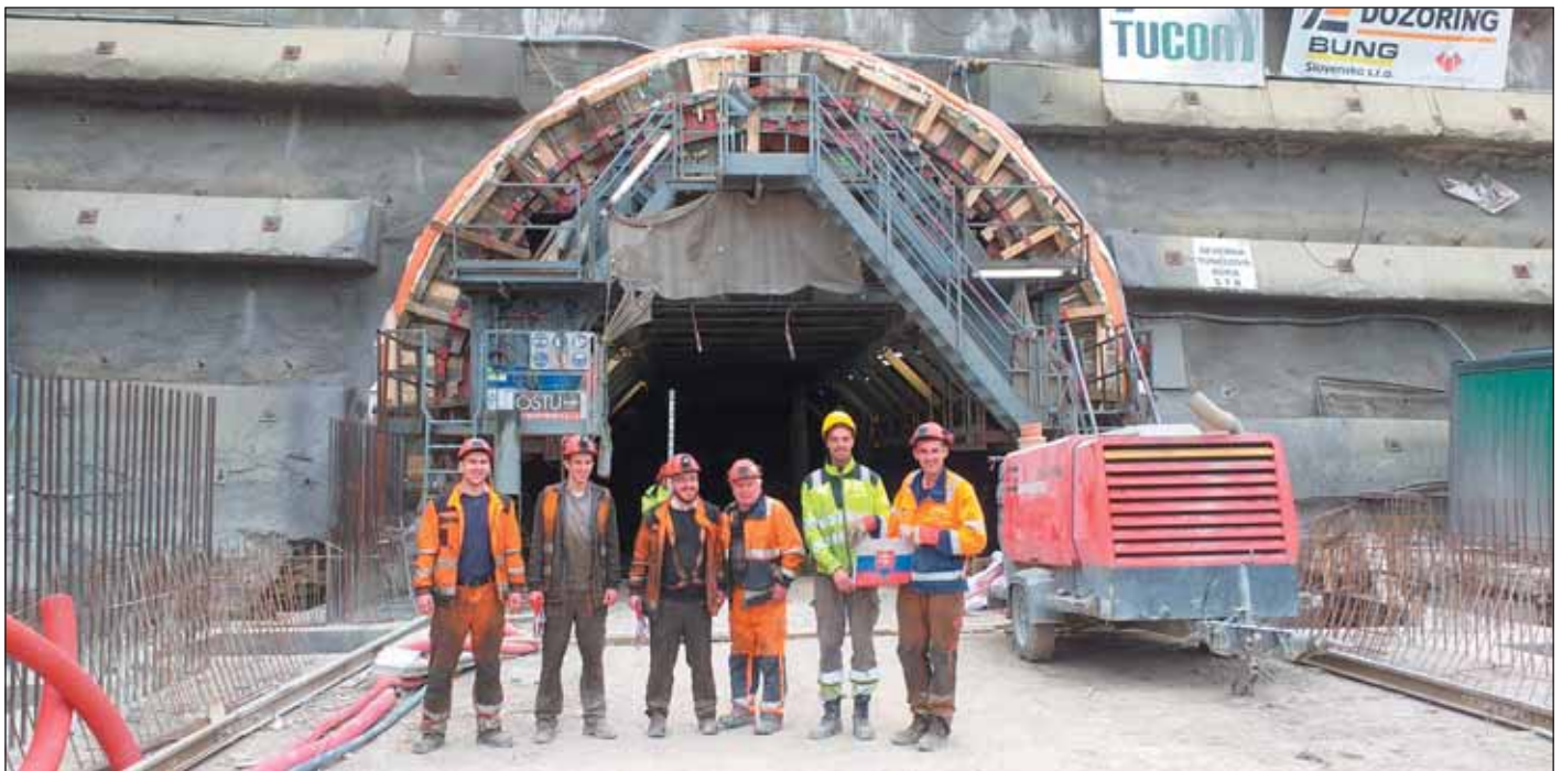
Obr. 10 Závěrečný betonovaný blok horní klenby v raženém úseku STT Fig. 10 Final concreted block of upper vault in the mined NTT section
