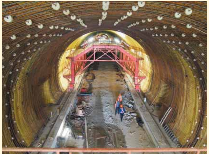
Obr. 5 Tunel Deboreč, realizace sekundárního ostění Fig. 5 Deboreč tunnel, work on secondary lining
