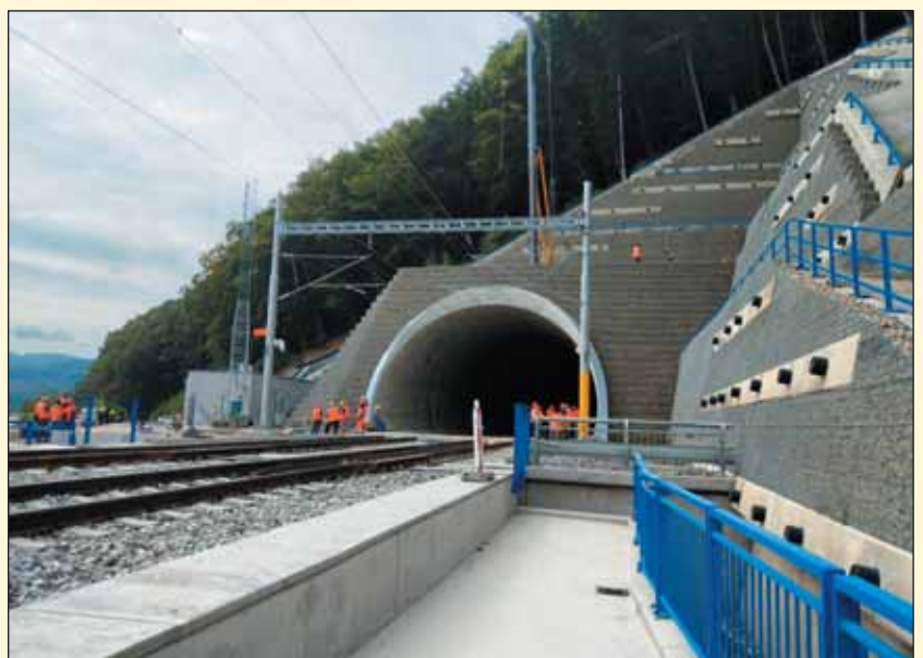
Obr. 8 Východný portál tunela Diel Fig. 8 Eastern portal of Diel tunnel
