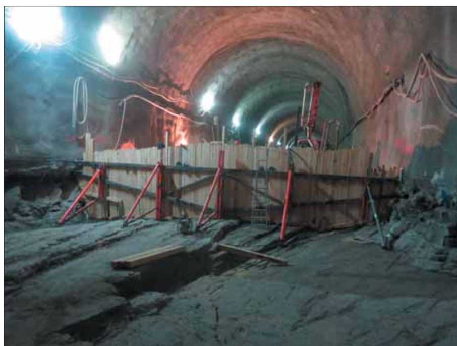
Obr. 6 Bednění čela bloku výplňového betonu dna Fig. 6 Formwork of mass fill concrete block of bottom
