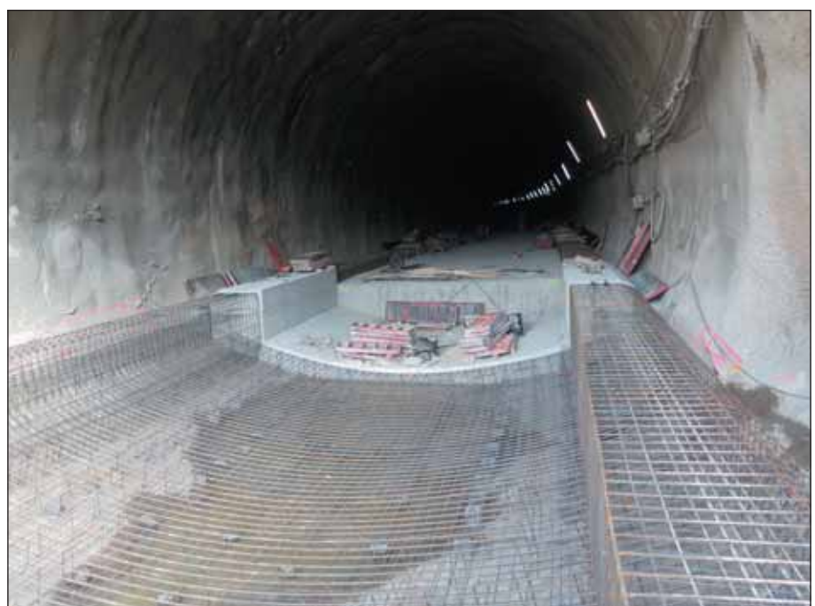
Obr. 4 Armatura spodní klenby Fig. 4 Invert concrete reinforcement
