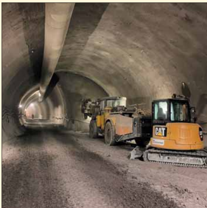
Obr. 1 Lokalita VO-OL, pohled do průzkumné štoly v části rozšířené na plný profil budoucího dvoukolejného tunelu
