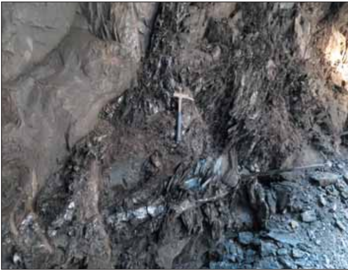
Obr. 7 Výrazně tektonické pásmo zastižené v úvodním úseku štoly VO-OL Fig. 7 Significantly faulted zone encountered in the initial section of VO-OL gallery
