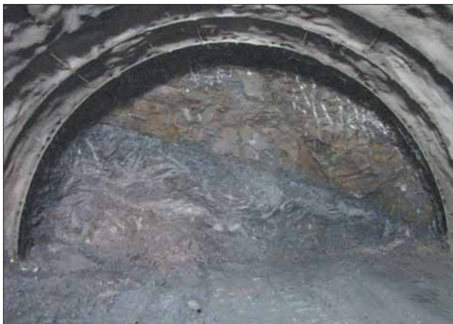
Obr. 8 Čelba v TM 357,8 – dílčí rozhraní na jednom ze zlomů hlavního směru uvnitř zlomové zóny Fig. 8 Excavation face at TM 357.8 – partial interface on one of faults of the main trend inside a fault zone
