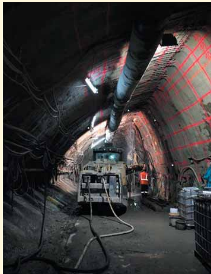
Obr. 3 Lokalita PAD4, pohled do průzkumné štoly a příprava pro provádění chemických injektáží
