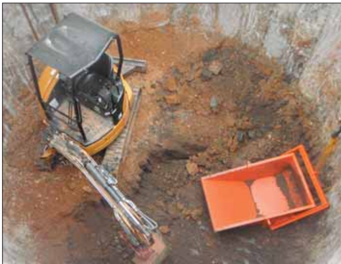
Obr. 12 Hloubení šachty OLI na přechodu terasových písčitéch štěrků a vrchních zcela zvětralých poloh břidlic bohdaleckého souvrství
