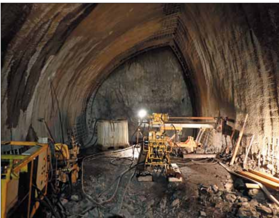
Obr. 9 Realizace horizontálního průzkumného vrtu presiometrického profilu PP01 Fig. 9 Drilling for the horizontal survey borehole in the PP01 pressuremeter profile
