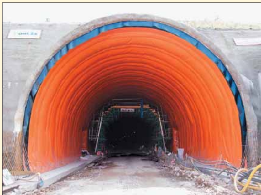
Obr. 4 Tunel Mezno, zahájení prací na sekundárním ostění Fig. 4 Mezno tunnel, commencement of work on secondary lining
