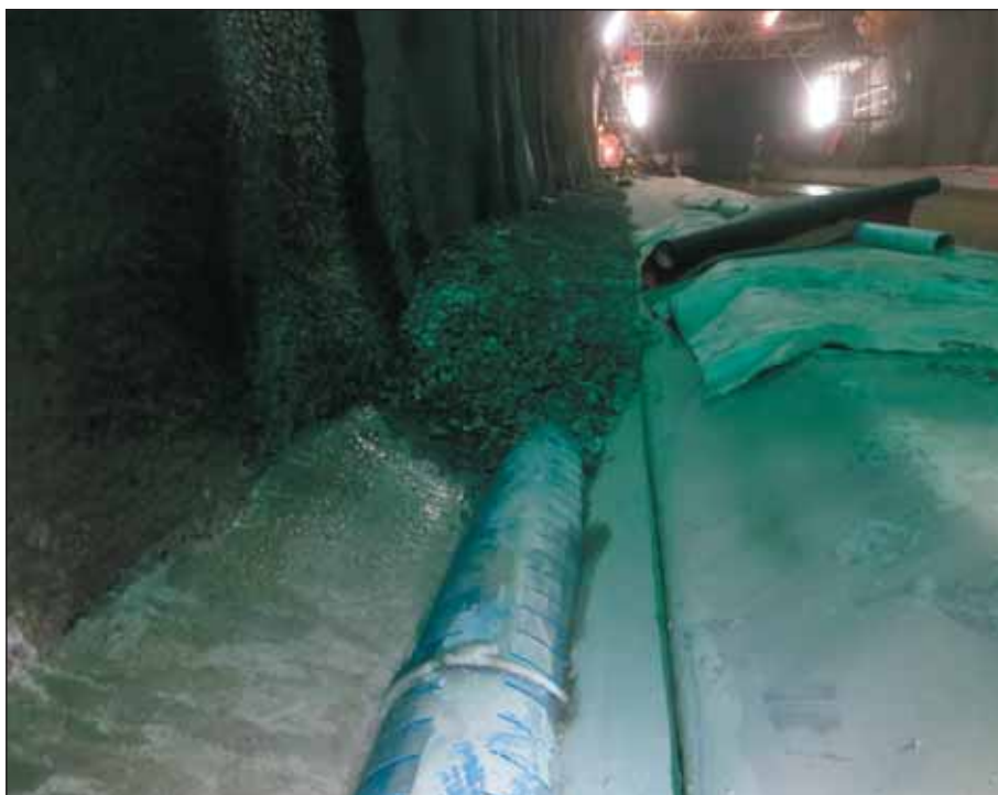
Obr. 7 Drenáž tunelu Fig. 7 Tunnel drainage
