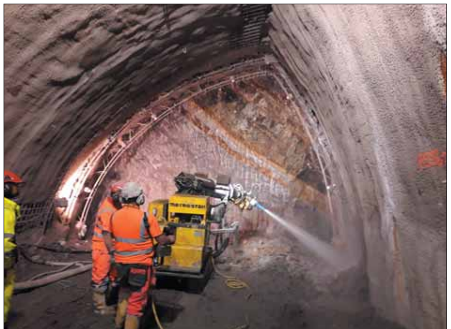
Obr. 8 Manipulátor Meyco Oruga a typická čelba v kosovském souvrství – nahoře křemence a dole břidlice
