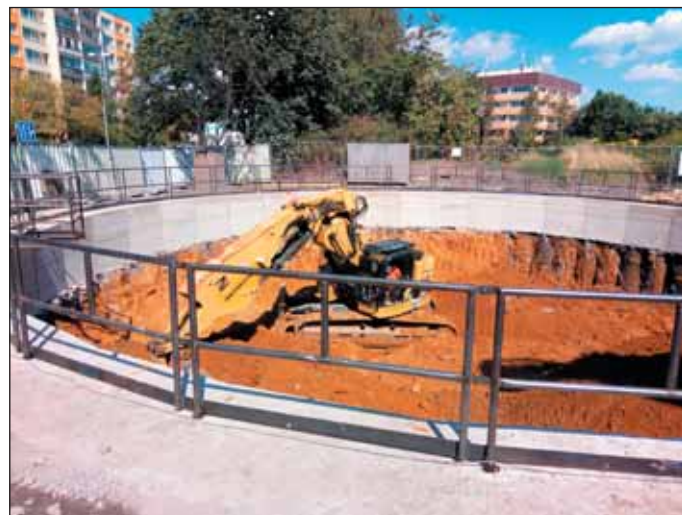
Obr. 3 Hloubení úvodního úseku šachty VO-OL v prostředí písčivých štěrků pankrácké terasy
