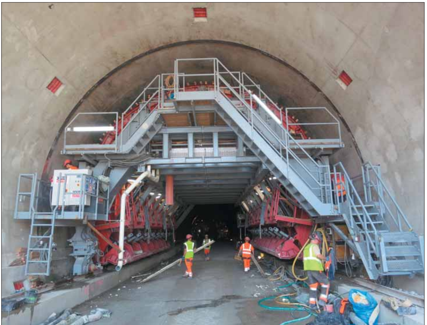
Obr. 9 Betonáž horní klenby definitivního ostění Fig. 9 Concreting of final lining upper vault
