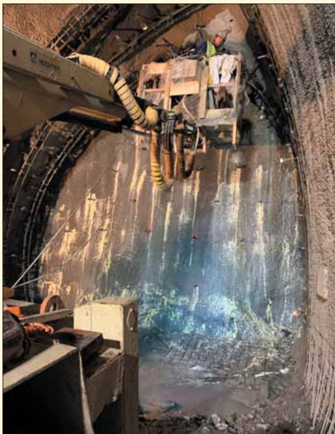
Obr. 2 Lokalita VO-OL, čelba průzkumné štoly v části profilu budoucího dvoukolejného tunelu
