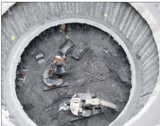
Obr. 4 Hloubení šachty VO-OL v prostředí břidlic bohdaleckého souvrství Fig. 4 Excavation of VO-OL shaft in the environment of Bohdalec Formation shale
