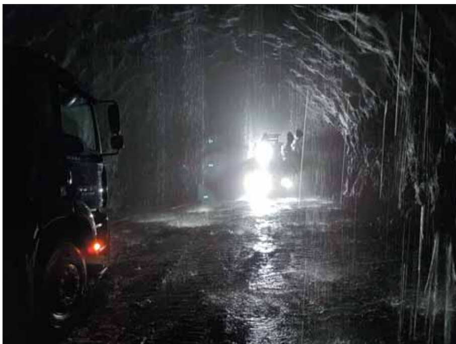
Obr. 6 Přítoky vody Fig. 6 Water inflows
