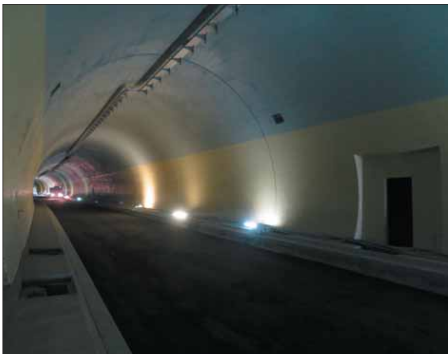
Obr. 11 Tunelová trouba po zhotovení nátěrů Fig. 11 Tunnel tube after application of paint
