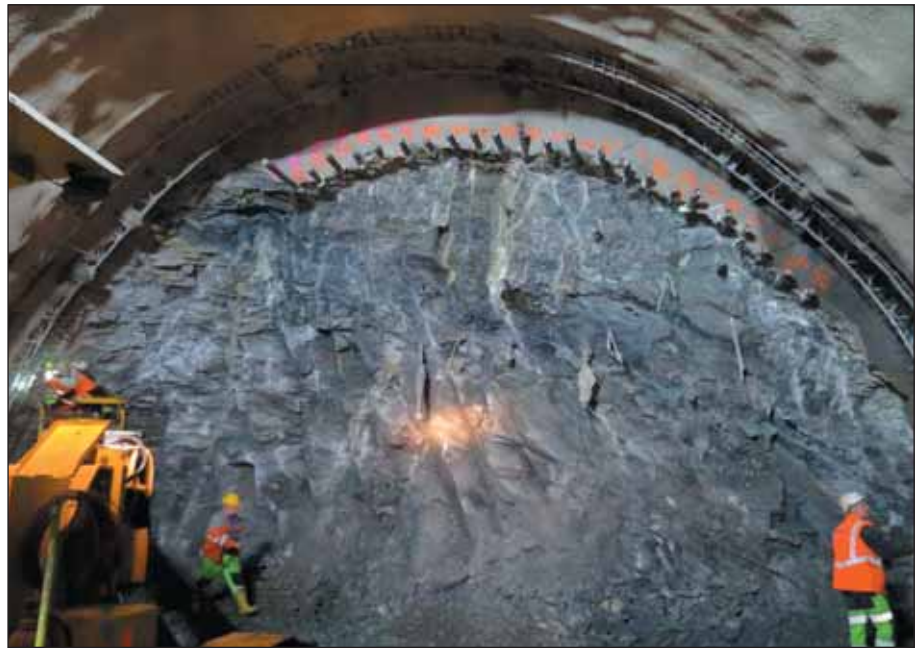
Obr. 10 Čelba v TM 412,0 – vyznívání zlomové zóny (vpravo nahoře) na kontaktu s navětralými až zdravými pararulami
