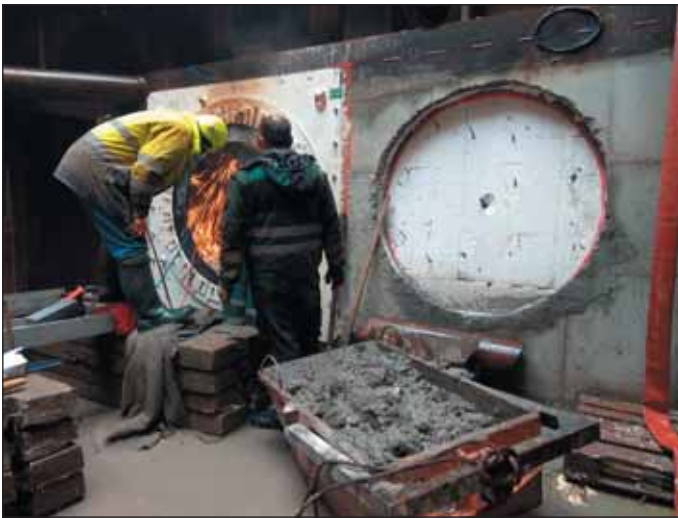
Obr. 6 Přední betonový blok s ocelovou deskou a gumovým těsněním, odřezávání štětovic v místě prostupu
