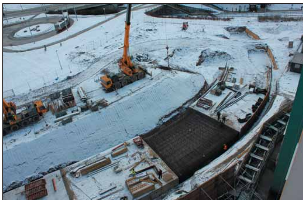
Obr. 7 Armování třetí dilatace definitivního stropu SO 602 na podzemních stěnách pod panelovým domem Mikuláškovo náměstí 10; dále navazuje SO 601 na stávající trať; leden 2021
