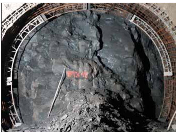
Obr. 5 Pohled na čelbu štoly při ražbě
