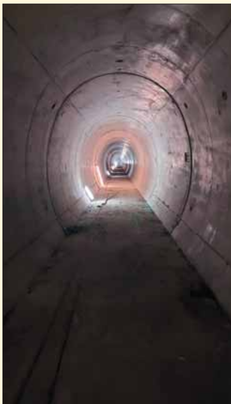
Obr. 10 Úniková štôľňa tunela Milochovo Fig. 10 Escape gallery of Milochovo tunnel
