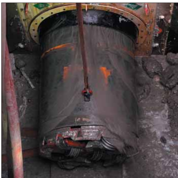
Obr. 10 Prorážka do cílové šachty Fig. 10 Breakthrough to receiving shaft
