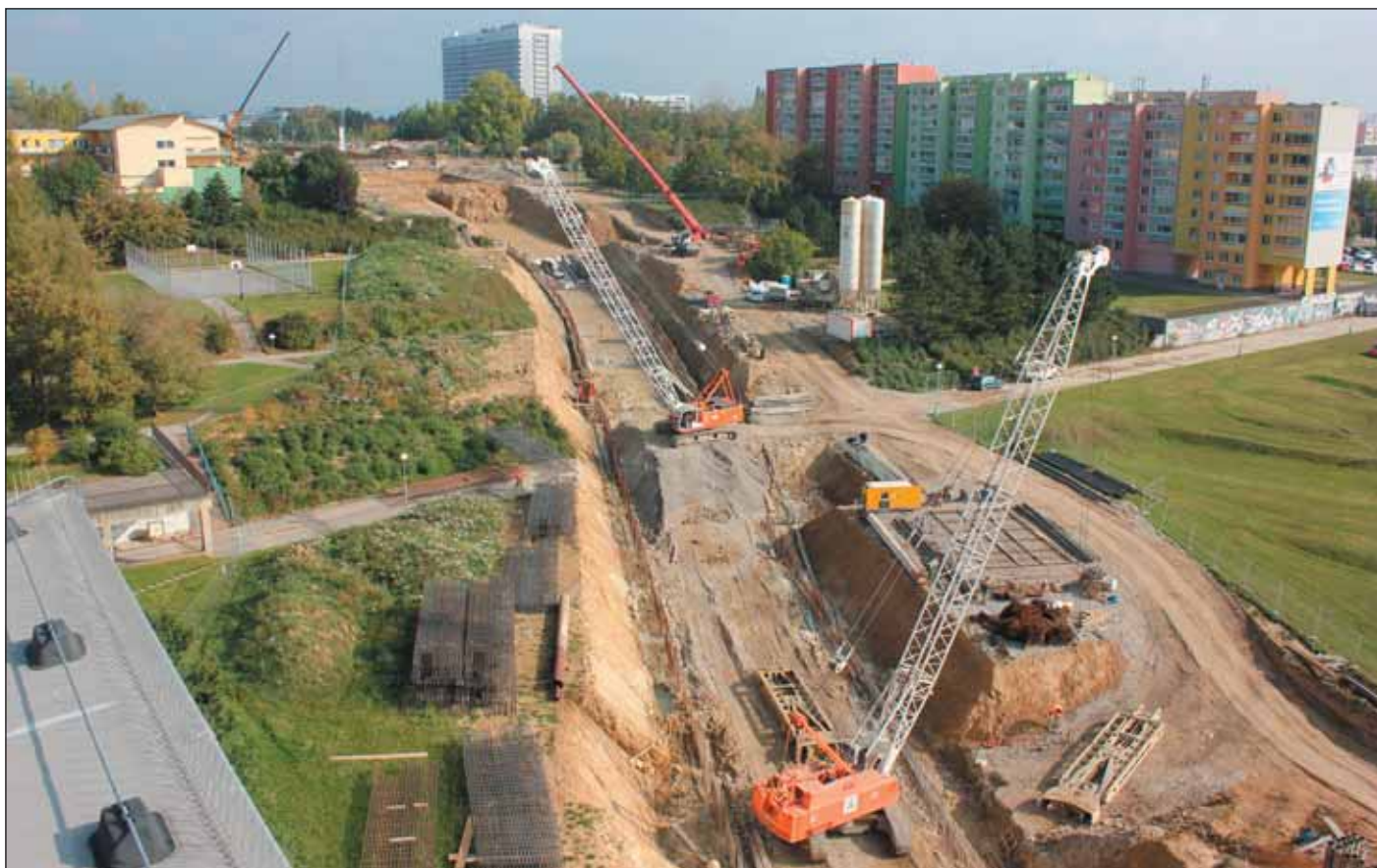
Obr. 6 Provádění podzemních stěn v oblasti Mikuláškova náměstí, SO 602; září 2020
