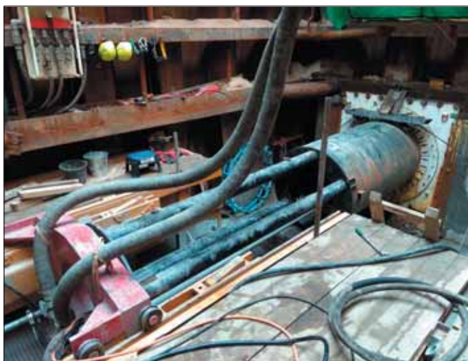
Obr. 5 Tlačný mezikus (spacer) použitý při protlačování Fig. 5 Intermediate jacking piece (spacer) used in pipejacking
