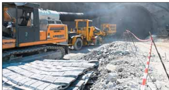
Obr. 6 Na rozpojování horniny byly nasazeny také trhačí práce
