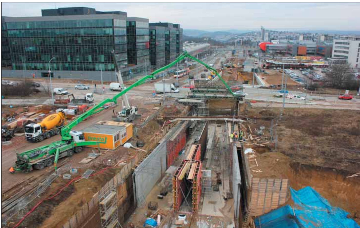
Obr. 9 Pohled na betonáž jedné ze stěn tunelu SO 604 a provizorní přemostění ul. Jihlavské; vpravo přesvahovaný výkop nad SO 603; únor 2021
