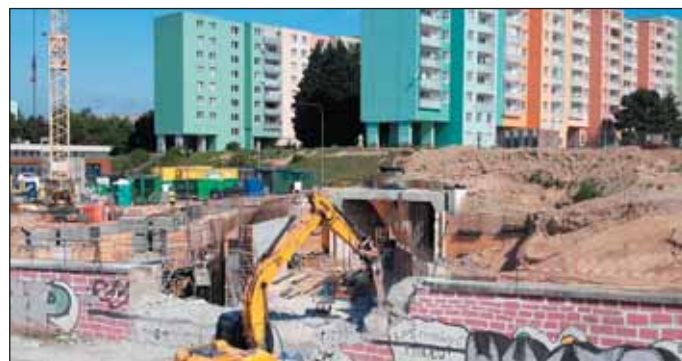
Obr. 2 Pohled na jámu SO 601 a na „provizorní portál“ z obr. 1 z protější strany o pět měsíců později – 07/2021
