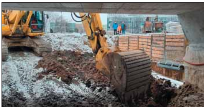
Obr. 1 Pohled z tunelu SO 602 v místě „provizorního portálu“ do budoucí jámy SO 601 – 02/2021
