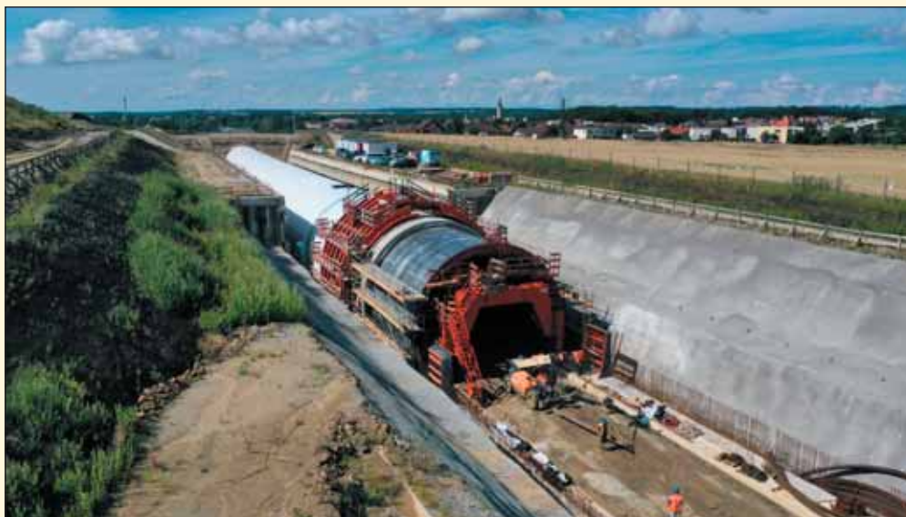
Obr. 5 Betonáž ostění ve svahovaném úseku stavební jámy Zvěrotice (stav k 16. 7. 2021)
