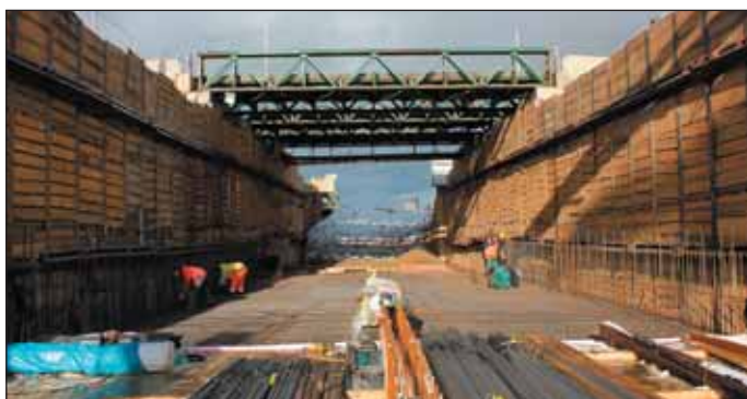
Obr. 5 Pohled do jámy stanice Nová Jihlavská SO 603 a navazujícího tunelu pod ulicí Labská SO 604 – 01/2021
