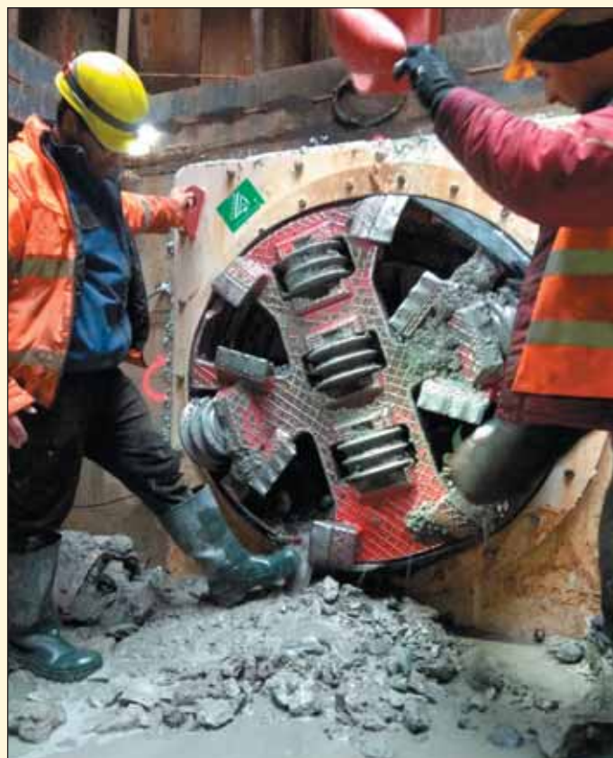
Obr. 2 Mikrotunelovací stroj Fig. 2 Mikrotunel boring machine
