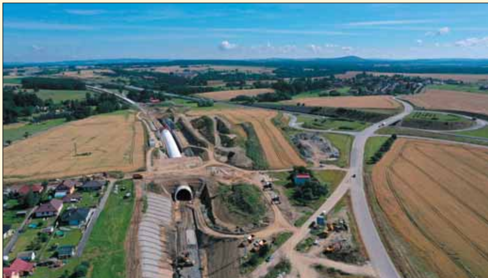
Obr. 4 Začlenění tunelu Zvěrotice do krajiny a proudový postup výstavby Fig. 4 Incorporation of Zvěrotice tunnel into landscape and the streamlined construction process
