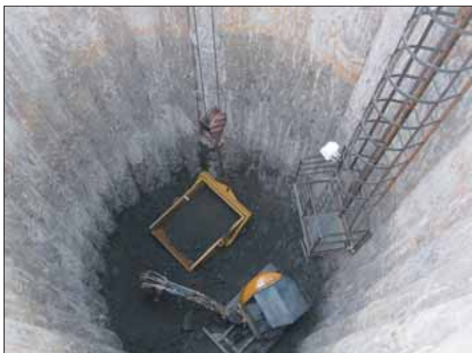
Obr. 7 Hloubení šachty OLI Fig. 7 OLI shaft sinking
