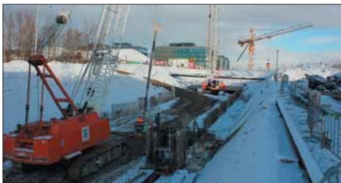
Obr. 3 Pohled na hloubení posledních podzemních stěn tunelu SO 602 – 01/2021
