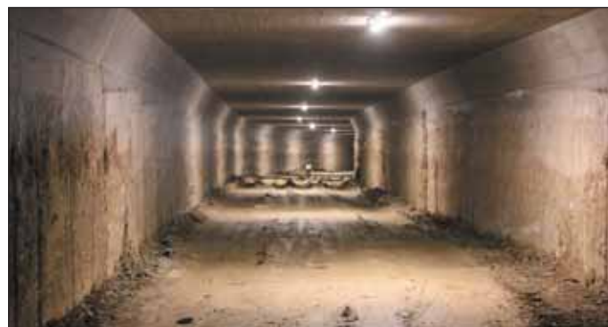
Obr. 4 Pohled na tytéž podzemní stěny jako na obr. 3 o šest měsíců později a deset metrů hlouběji – 07/2021
