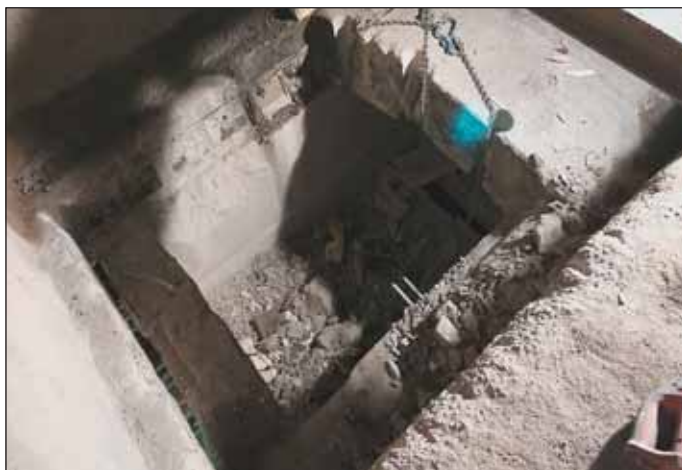
Obr. 5 Průběh demontáže tubingů Fig. 5 Lining segments disassembly process
