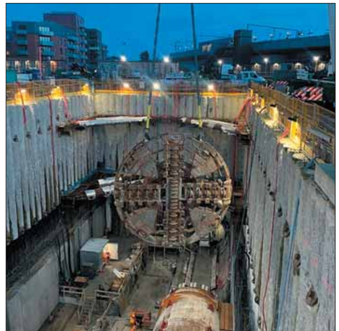
Obr. 3 Zvedání řezné hlavy štítu ze dna šachty
