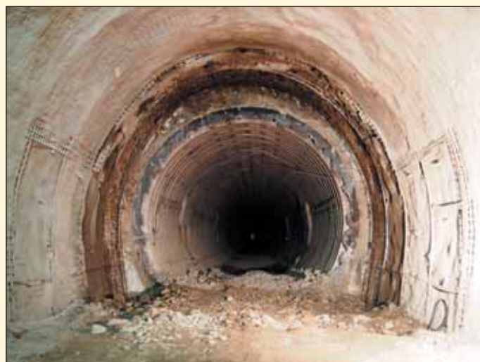
Obr. 4 Porovnání původního profilu se segmentovým ostěním a nově budovaného profilu zajištěného primárním ostěním
