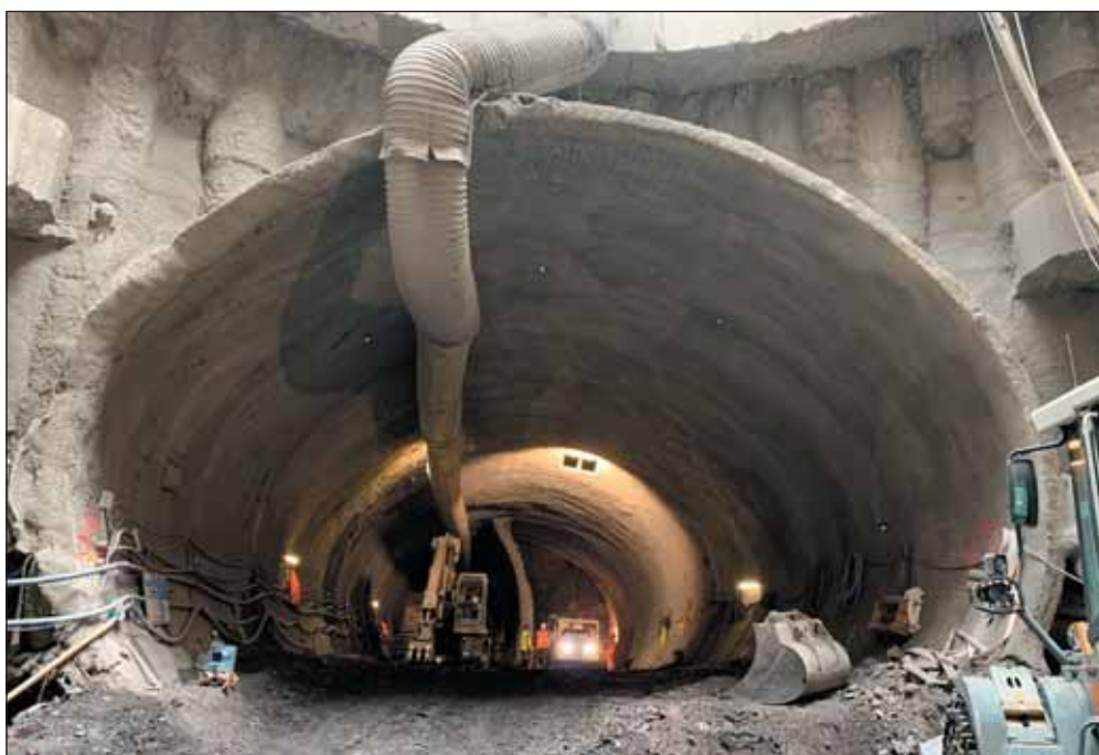
Obr. 7 Pohled na rozšíření díla v portálové části Fig. 7 A view of the expanded tunnel in the portal part
