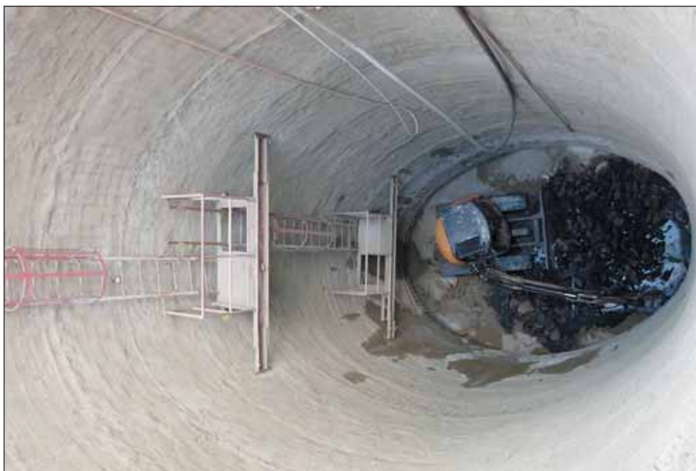
Obr. 1 Hloubení šachty Š1 v eliptickém profilu Fig. 1 Excavation of the elliptical profile shaft Š1
