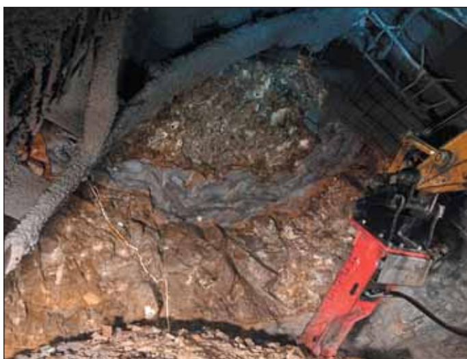
Obr. 5 Diskontinuity vyplnění injektážní směsí v kosovském souvrství Fig. 5 Filling of discontinuities in the Kosov Formation with grouting mixture
