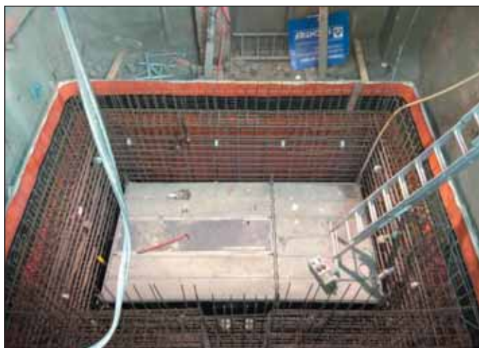
Obr. 8 Armatura sekce BS110
