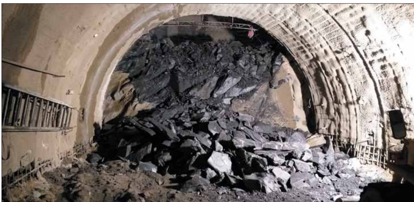
Obr. 4 Průnik přestupní chodby s šachtou Š2
