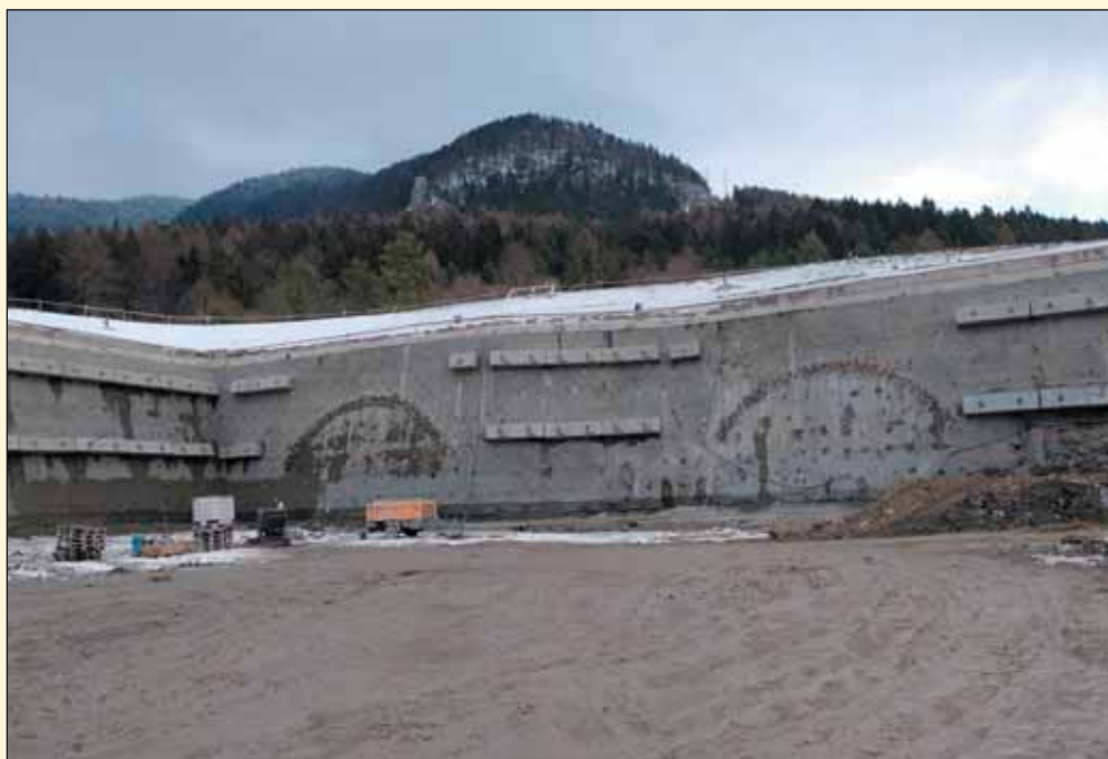
Obr. 7 Západný portál tunela Čebrať Fig. 7 Western portal of the Čebrať tunnel
