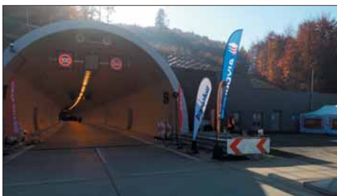
Obr. 5 Portál južnej tunelovej rúry Fig. 5 Portal of southern tunnel tube
