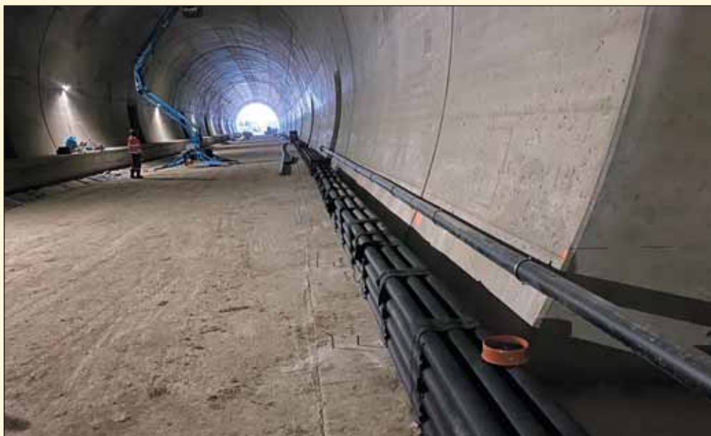
Obr. 5 Chráničky kabelovodu a potrubí požárního vodovodu Fig. 5 Cable protection pipes and fire water pipeline
