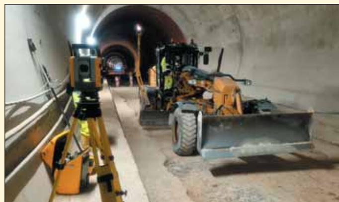
Obr. 9 Úpravy dna v tuneli Višňové Fig. 9 Work on the bottom of the Višňové tunnel
