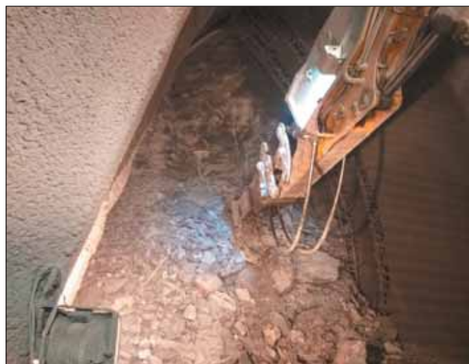
Obr. 4 Strojní rozpojování v patním tunelu
