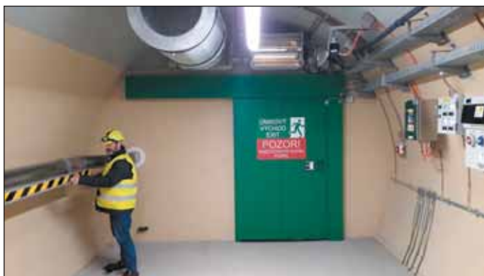
Obr. 7 Suchovod v priečnom prepojení
