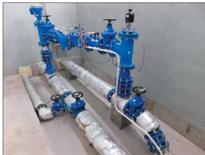
Obr. 6 Zostava na redukciu tlaku požiarneho vodovodu
