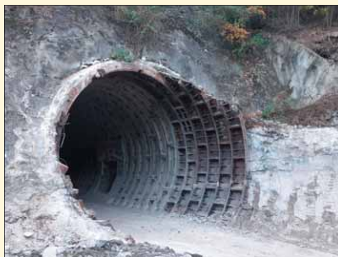
Obr. 3 Demolice vjezdového hloubeného tunelu, který byl tvořen krajním železobetonovým monolitickým blokem a úsekem z obetonovaných litinových tubingů
