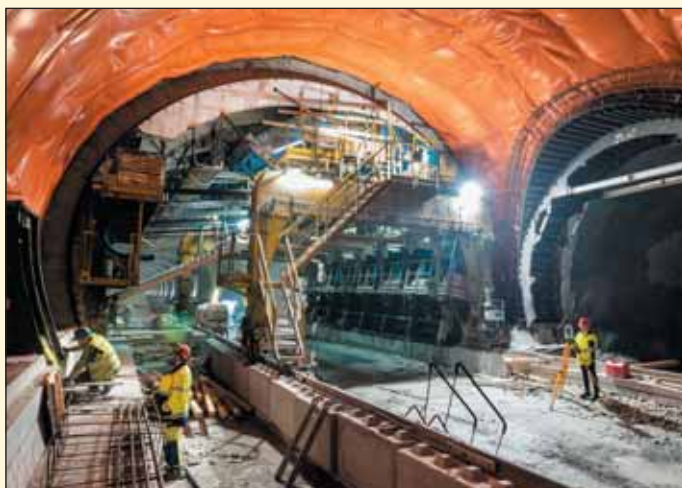
Obr. 8 Príprava betonáže ostenia v núdzovom zálive tunela Višňové Fig. 8 Preparation of concreting the lining in emergency lay-by in the Višňové tunnel
