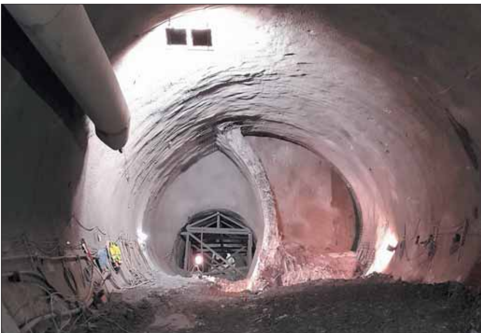
Obr. 10 Ražba druhého dílčího výrubu pod linkou metra C Fig. 10 Second partial excavation under metro C line
