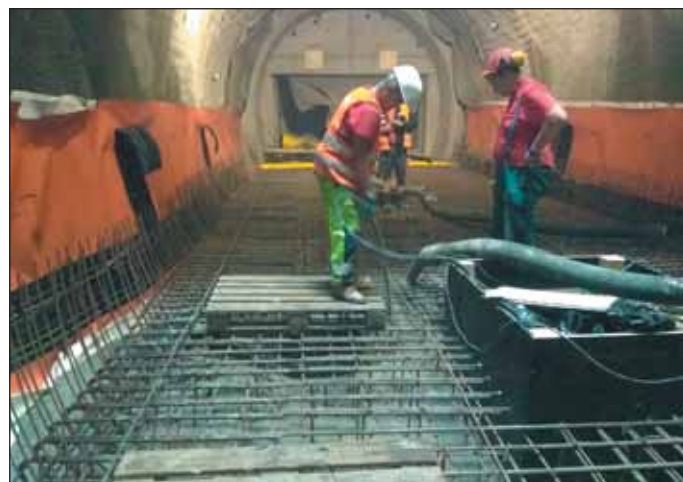
Obr. 9 Betonáž spodní klenby přestupní chodby
