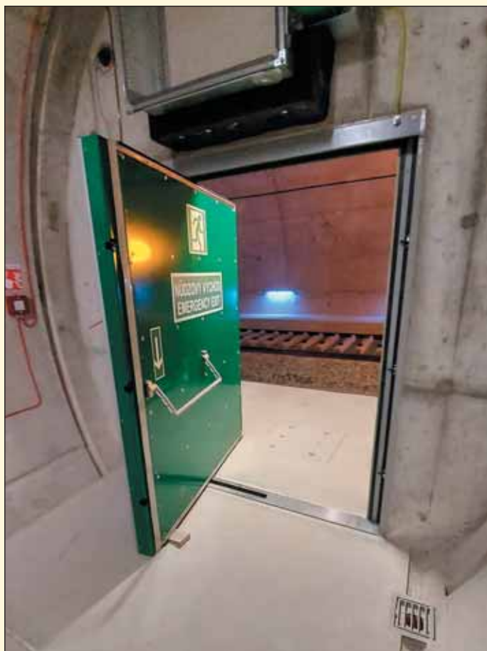
Obr. 10 Únikový východ z tunela Milochov Fig. 10 Escape exit from the Milochov tunnel
