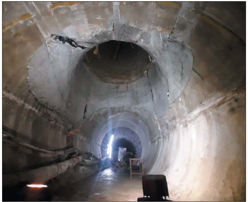
Obr. 10 Betonáž prepojenia
