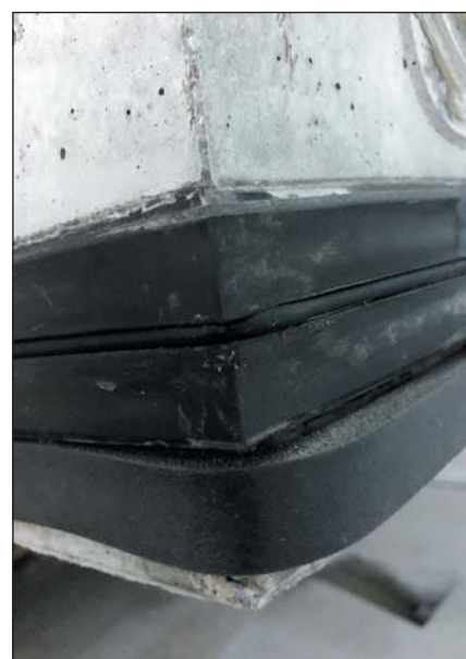
Obr. 11 Segmentové tesnenie zapustené v betóne so stredovou kruhovou drážkou na uloženie napačiavacieho pásiku Fig. 11 Segment sealing gaskets embedded in concrete, with a circular groove in the middle for placing a swelling strip
