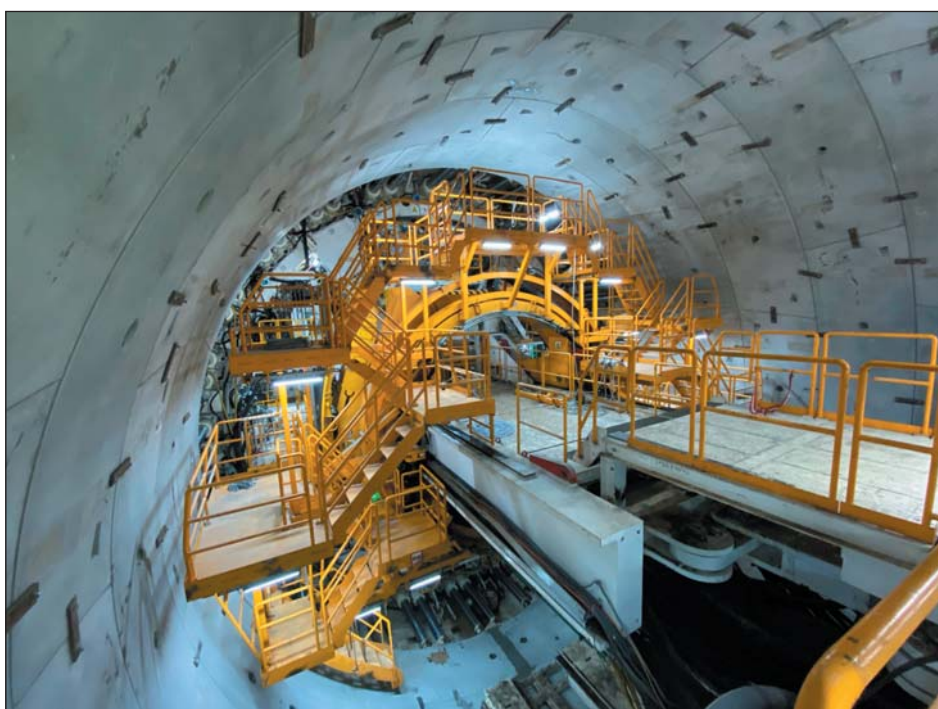
Obr. 10 Montáž ostenia Fig. 10 Assembly of lining
