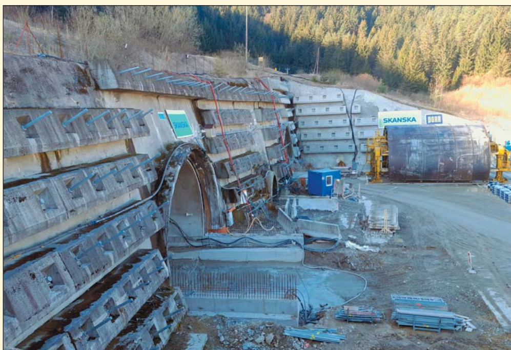
Obr. 4 Priestor západného portálu tunela Višňové
