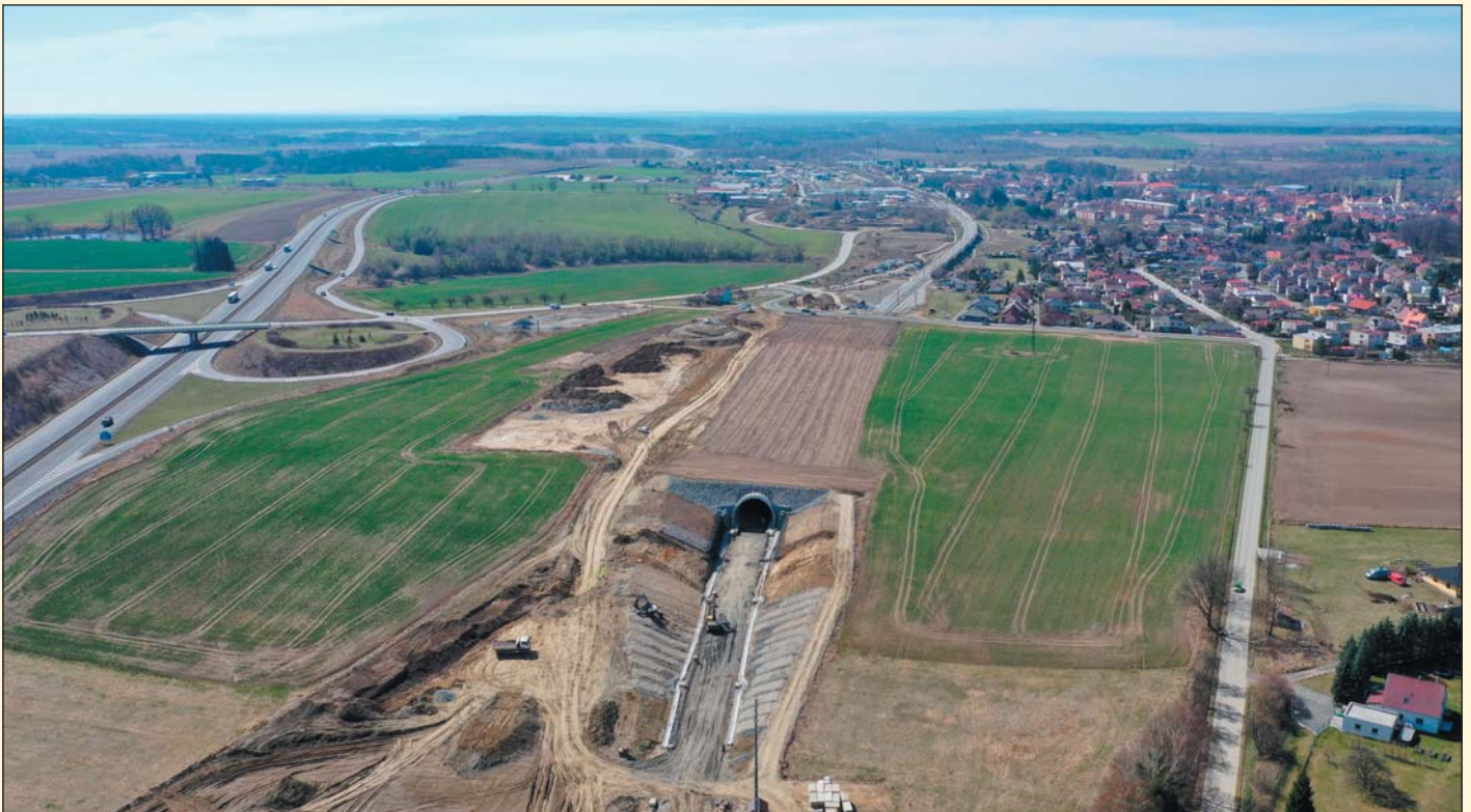
Obr. 3 Dokončení zásypů stavební jámy (duben 2022)
