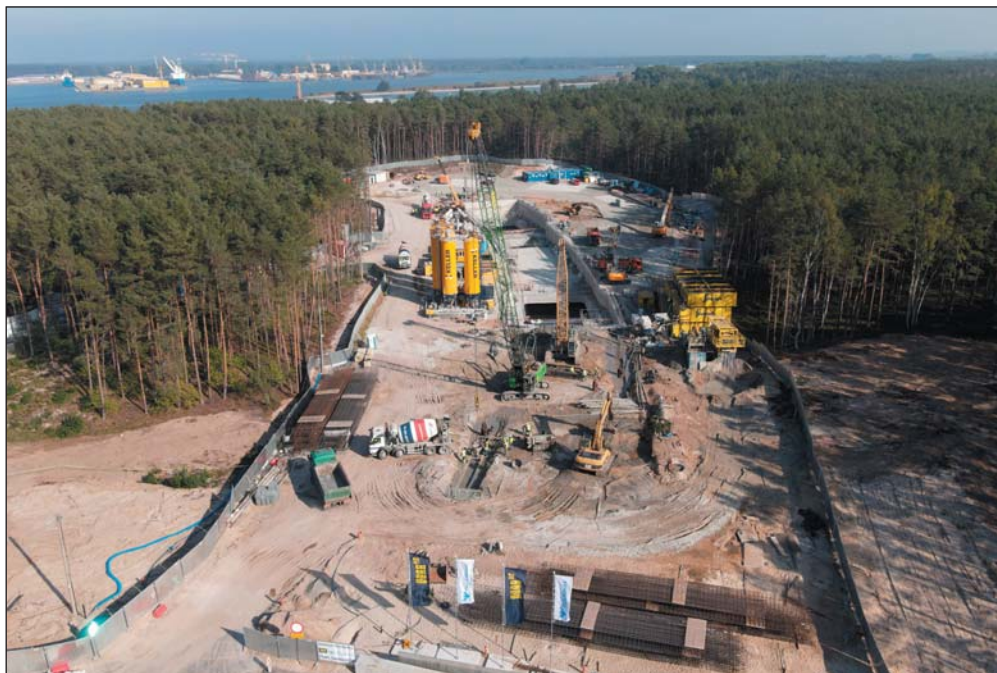
Obr. 9 Pohľad na výstavbu štartovacej jamy tunela Fig. 9 View of the construction of the launching shaft
