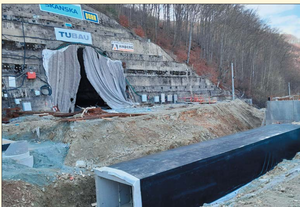
Obr. 5 Výstavba kolektoru na východnom portáli tunela Višňové
