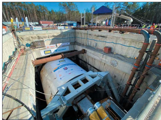
Obr. 6 Štartovacia jama so štítom Fig. 6 Launching shaft with the shield
