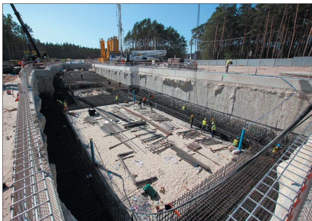
Obr. 8 Výstavba jamy a konštrukčných rámp Fig. 8 Construction of the shaft and construction ramps
