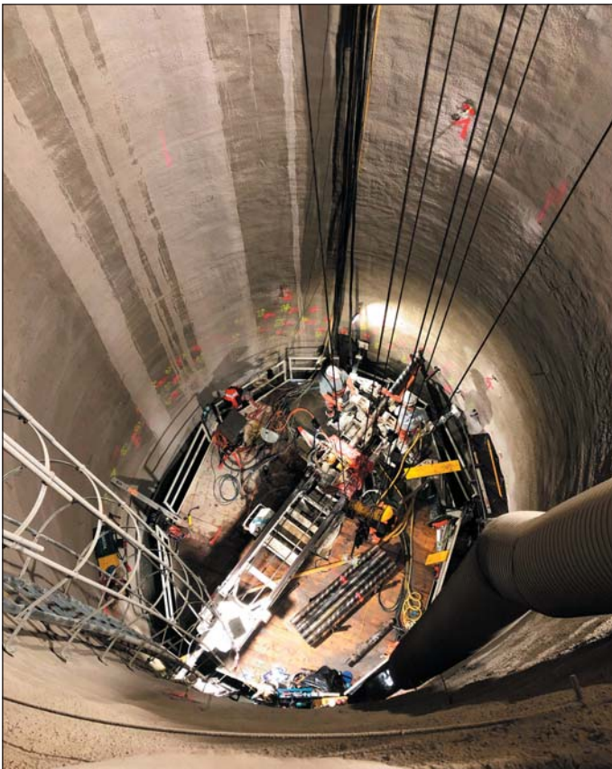
Obr. 7 Šachta vybudovaná pre kompenzačné vrty sadania ÖBB Fig. 7 Shaft carried out for ÖBB settlement compensation
