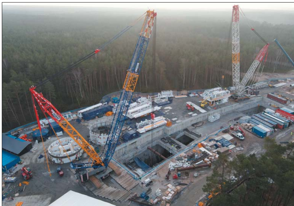
Obr. 5 Montáž bentonitového štítu Fig. 5 Assembly of the slurry shield
