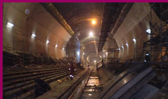
Metrá, podzemné dráhy
