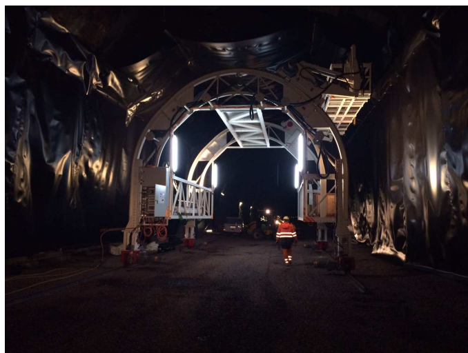
Obr. 1 Hydroizolačný voz Fig. 1 Waterproofing gantry
