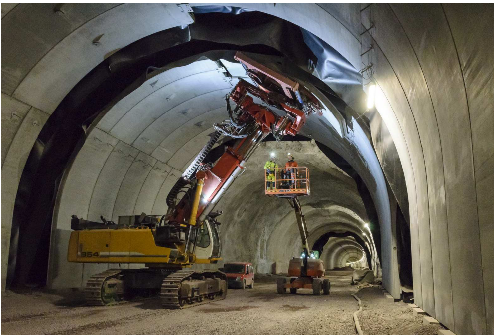
Obr. 2 Manipulátor Liebherr 954 pri inštalácii stropného panelu Fig. 2 Forklift Liebherr 954 when installing ceiling panels
