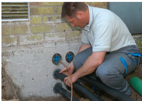
Obr. 1 V mnohých prípadoch je potrebné, aby protipožiarné prestupy boli aj vodotesné Fig. 1 In many cases is needed, that fire protection transit must be also watertight
