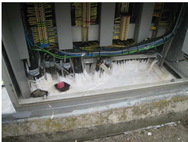
Obr. 4 Príklady ohrozenia a znefunkčenia protipožiarneho prestupu hlodavcami Fig. 4 Examples of fire protection transits devaluation by rodents
