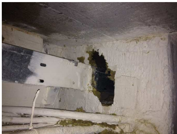
Obr. 4 Príklady ohrozenia a znefunkčenia protipožiarneho prestupu hlodavcami Fig. 4 Examples of fire protection transits devaluation by rodents
