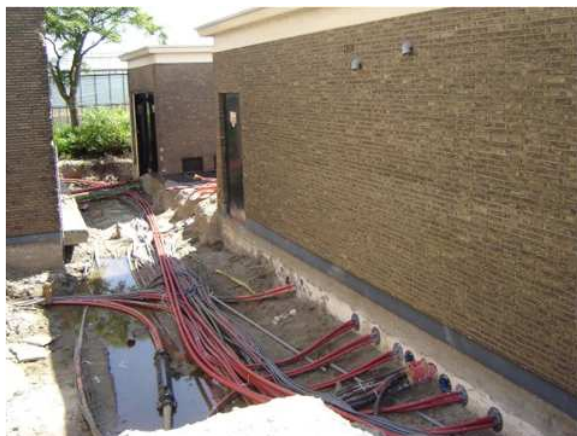
Obr. 1 V mnohých prípadoch je potrebné, aby protipožiarné prestupy boli aj vodotesné Fig. 1 In many cases is needed, that fire protection transit must be also watertight
