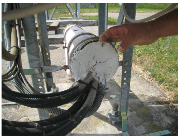
Obr. 6 Mäkké protipožiarne upchávky dlho nevydržia a treba ich často renovovať. Zvyšujú sa tým prevádzkové náklady a navyše aj riziko požiaru a zatekania.
