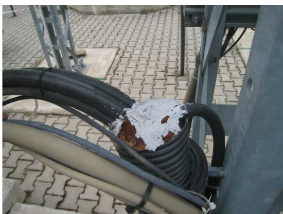
Obr. 6 Mäkké protipožiarne upchávky dlho nevydržia a treba ich často renovovať. Zvyšujú sa tým prevádzkové náklady a navyše aj riziko požiaru a zatekania.
