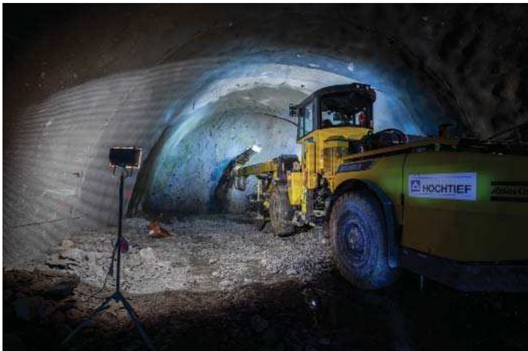
Obr. 5 Vrtací voz Atlas-copco Rocket boomer E2C Fig. 5 Drill rig Atlas-copco Rocket boomer E2C
