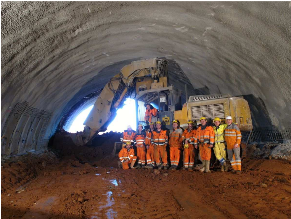
Obr. 5 Prerazenie západnej tunelovej rúry Fig. 5 Break-through of the west tunnel tube
