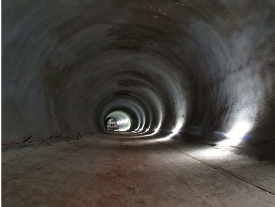
Obr. 3 Primárne ostenie tunelovej rúry Fig. 3 Primary lining
