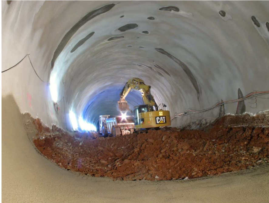
Obr. 2 Odt'azba červeného pieskovca z tunelovej rúry Fig. 2 Mucking of the red sandstone from the tunnel tube
