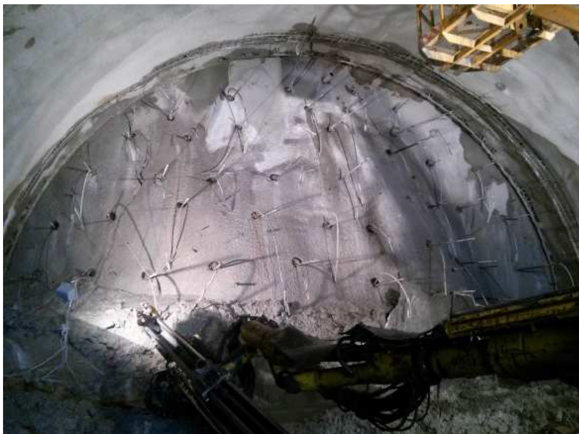
Obr. 5 Pohľad na masívne zakotvenie čelby Fig. 5 A view of the massive anchoring of the excavation face
