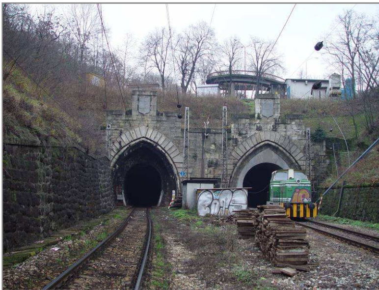
Obr. 1 Lamačský portál Bratislavského tunela č. I a II. a skutkový stav tunelového ostenia Fig. 1 Lamačský portal of Bratislava tunnel No. I and II and tunnel lining situation
