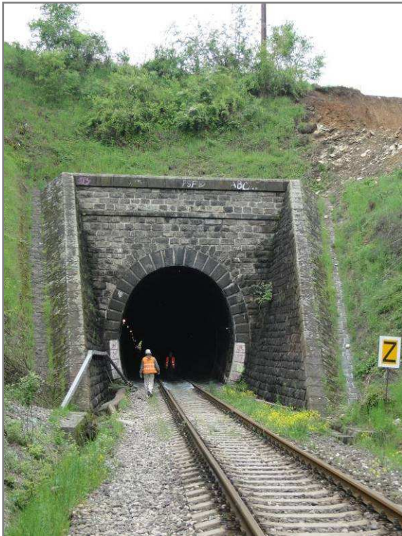
Obr. 2 Bystrický portál Banskobystrického tunela a skutkový stav tunelového ostenia Fig. 2 Bystrický portal of Banskobystrický tunel and tunnel lining situation
