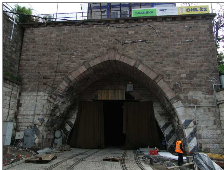
Obr. 3 Dunajský portál Bratislavského električkového tunela a skutkový stav tunel. ostenia Fig. 3 Dunajský portal of Bratislava tram tunnel and tunnel lining situation
