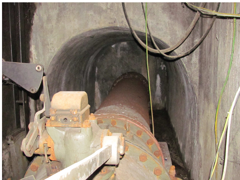
Obr. 2 Napojenie na vyrovnávaciu nádrž pred výmenou potrubia Fig. 2 Connection to the buffer tank before replacing pipes
