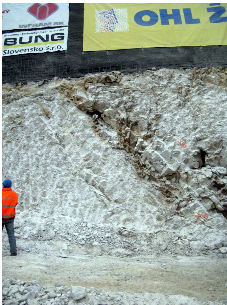
Obr. 10 Kaverny prítomné v zárubnej stene viazané na systémy diskontinuit Fig. 10 Caverns present in the breast wall bound to the discontinuities systems
