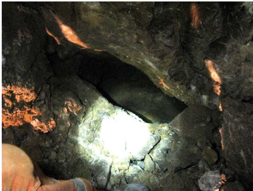
Obr. 3 Otvorená krasová dutina v dne kaloty v staničení 1587,8 tm Fig. 3 Karst cavity opened at the top heading of the stationing 1,587.8 tunnel m
