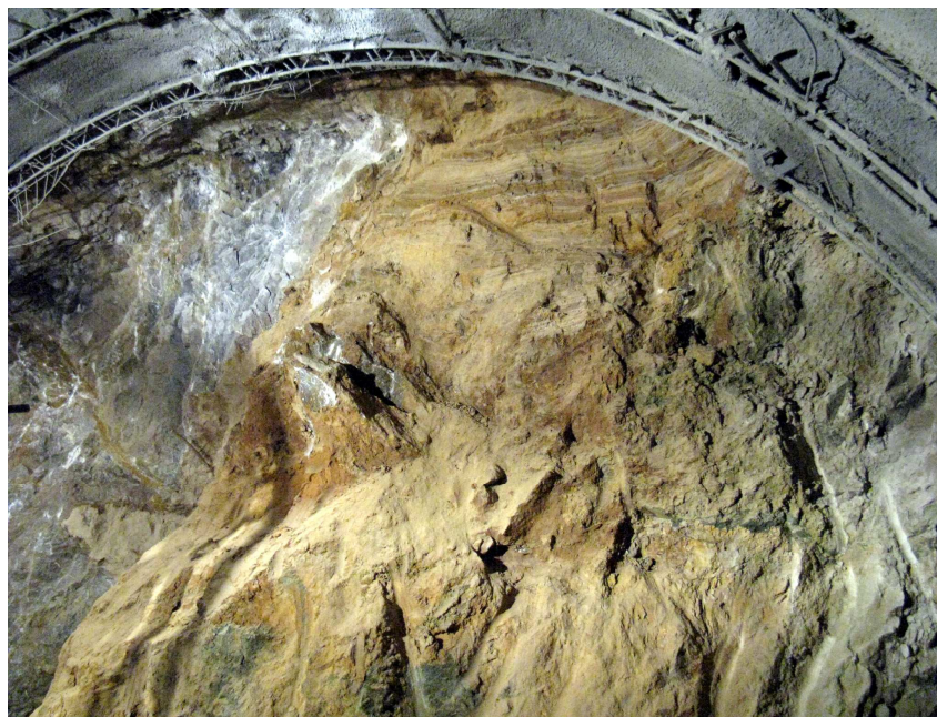
Obr. 6 Piesková a brekciová výplň kaverny (1486,1m, SK-188). V hornej časti je zreteľná laminovaná výplň po erózii. V prostrednej časti vyčnieva kamenný blok.
