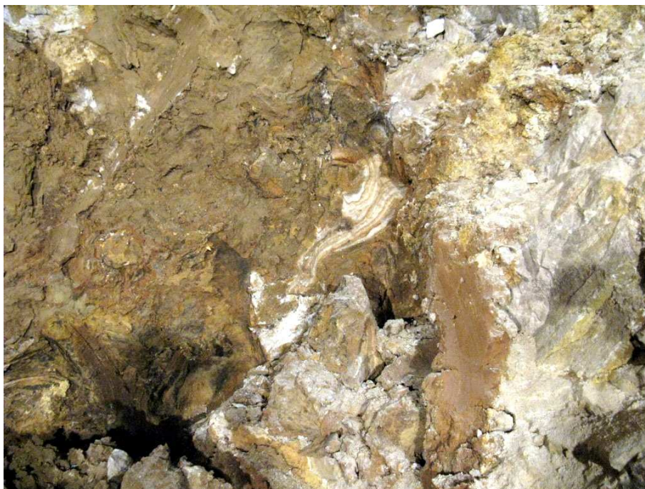
Obr. 2 Vrstva sintru na okraji krasovej kaverny v staničení 321,8 tm Fig. 2 Sinter layer on the edge of karst cavern in stationing 321.8 tunnel m
