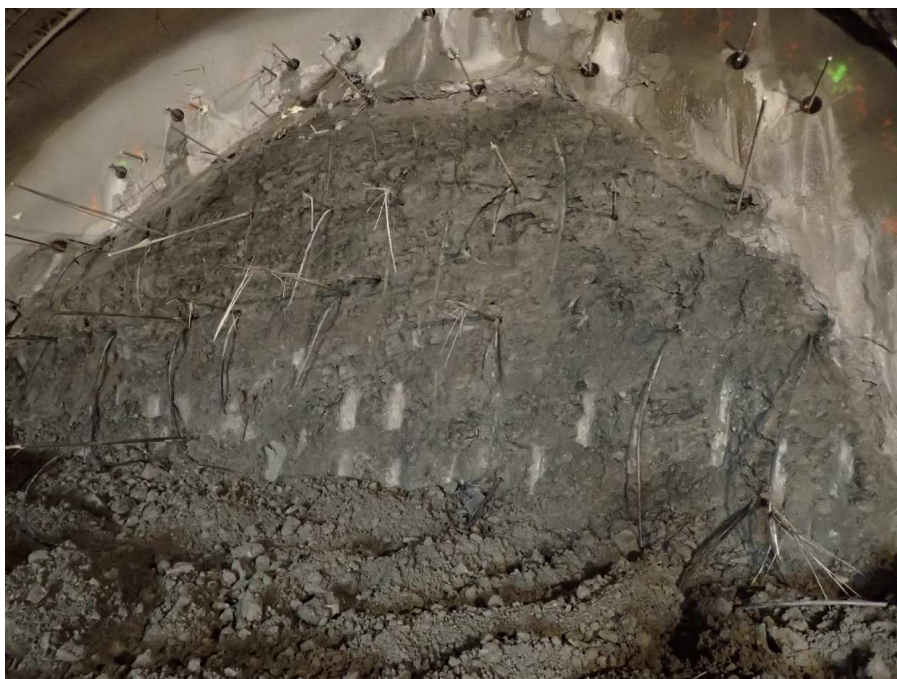
Obr. 5 Čelní pohled na kalotu v jižní tunelové rouře Fig. 5 Front view of the top heading in the southern tunnel tube
