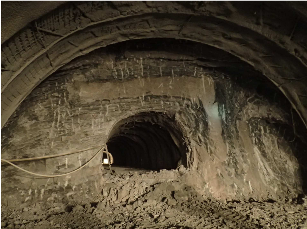
Obr. 3 Střídání poloh slepenců s jílovcí v severní tunelové rouře od západního portálu Fig. 3 Layer with Conglomerates and claystones in the northern tube from western portal
