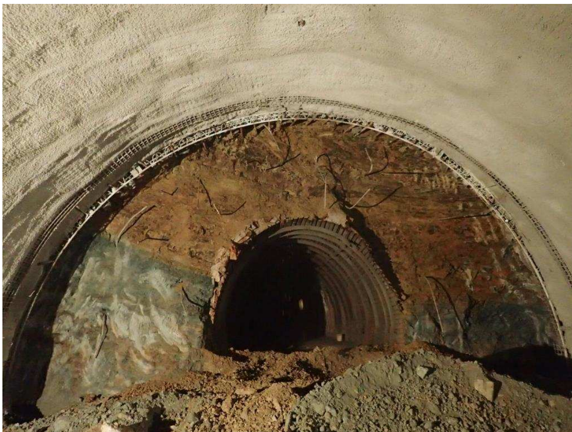
Obr. 4 Střídání poloh jílovců v severní tunelové rouře od východního portálu Fig. 4 Layers of claystones in the northern tube from eastern portal
