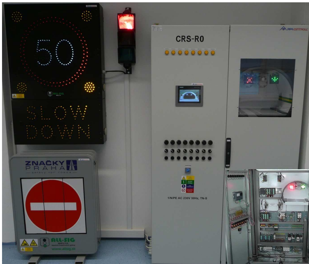
Obr. 5 Manuálny modul riadenia s detailom rozvážacej skrine
