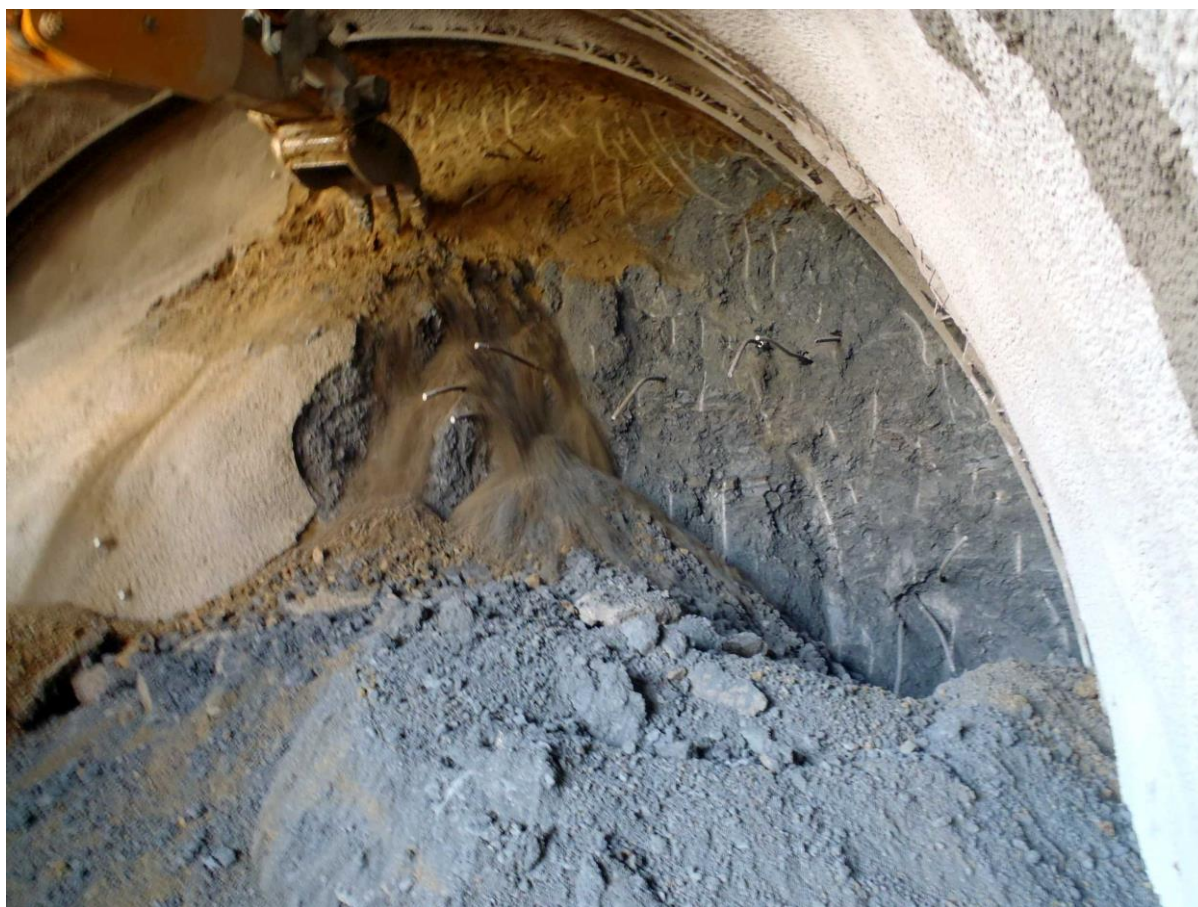
Obr. 1 Vysypávanie horniny z klenby kaloty
