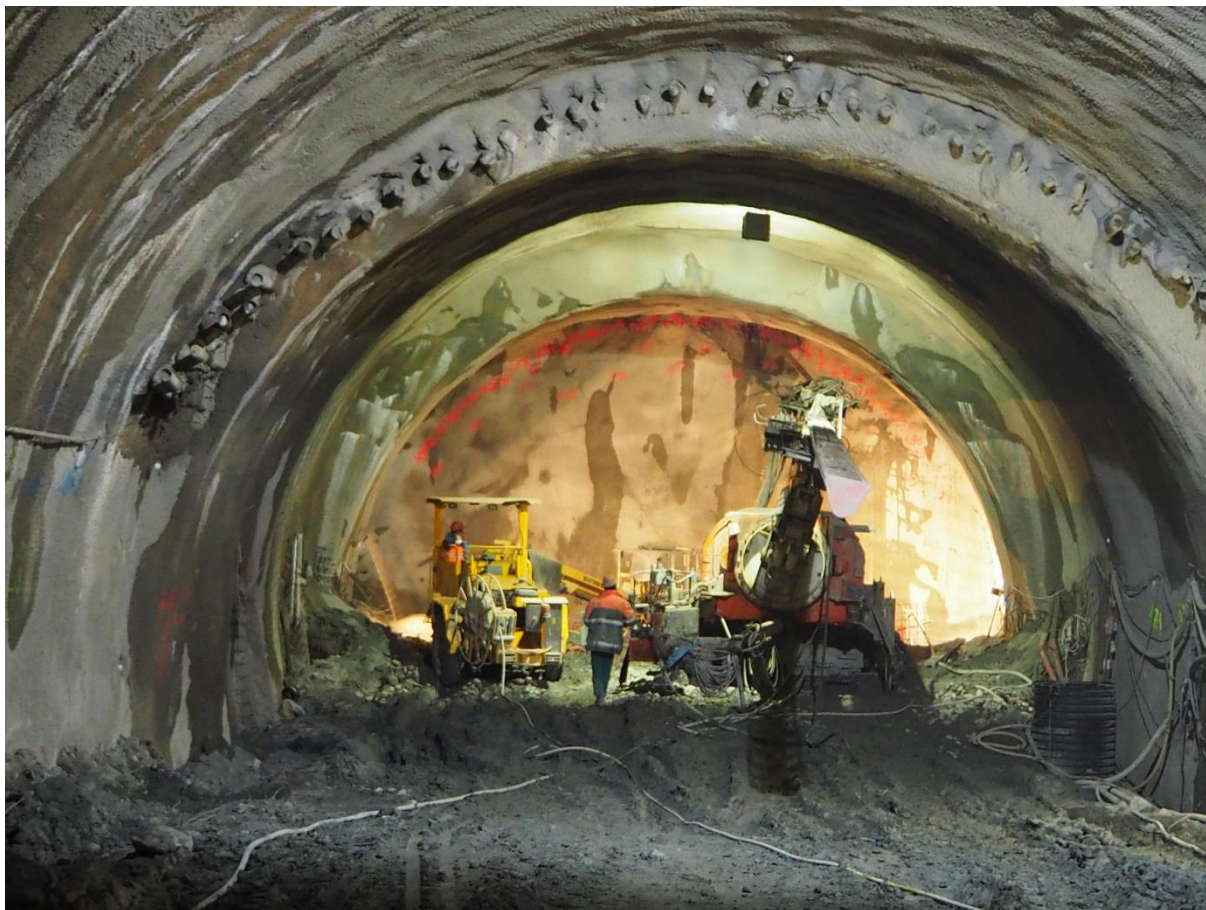
Obr. 2 Pohľad na mikropilotový dáždnik a vrtanie čelbových kotiev Zdroj: Doprastav, a.s.
