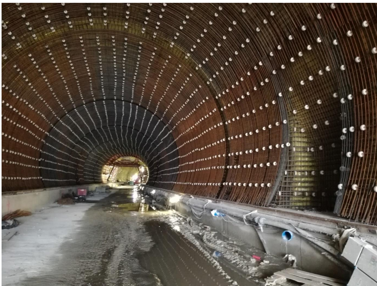
Obr. 3 Pohľad na výstuž hornej klenby sekundárneho ostenia Zdroj: Doprastav, a.s.
