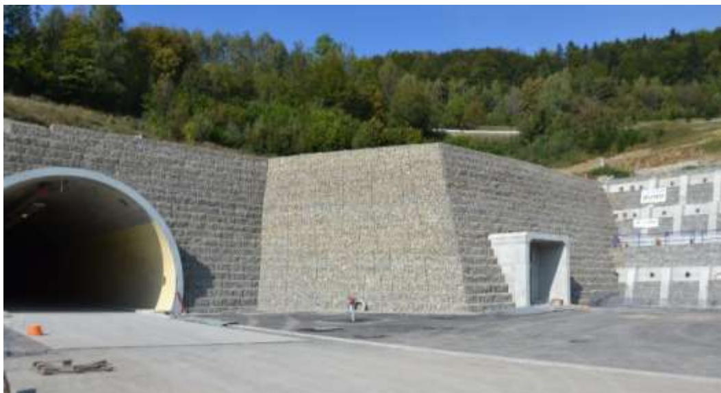
Obr. 8 Pohľad na východný portál tunela Poľana
