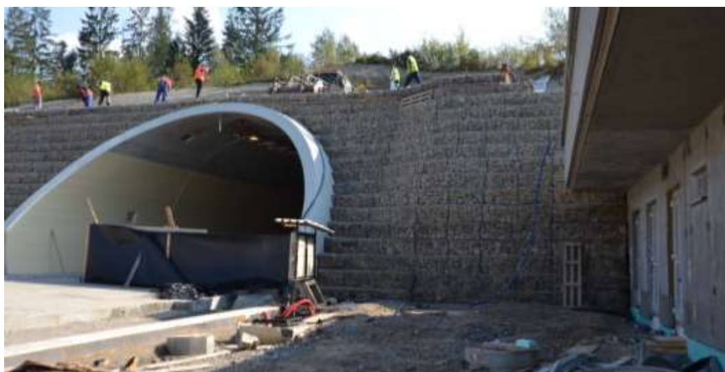
Obr. 3 Pohľad na východný portál tunela Svrčinovec
