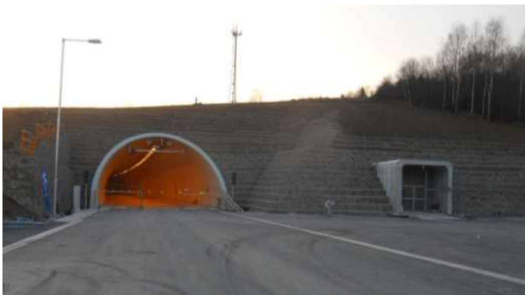
Obr. 9 Pohľad na východný portál tunela Svrčinovec
