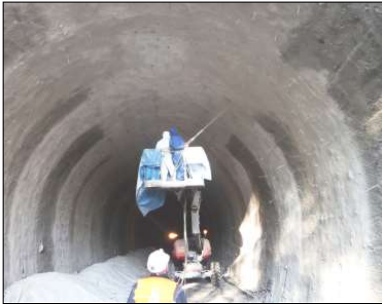
Obr. 3 Aplikácia membrány v Rigelskom tuneli. Fig. 3 Membrane application in Rigelsky tunel.
