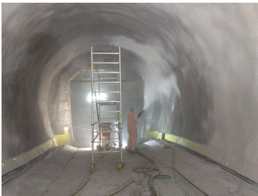
Obr. 3 Nanášení penetrační vrstvy stříkané izolace Fig. 3 Application of the adhesive layer of sprayed membrane
