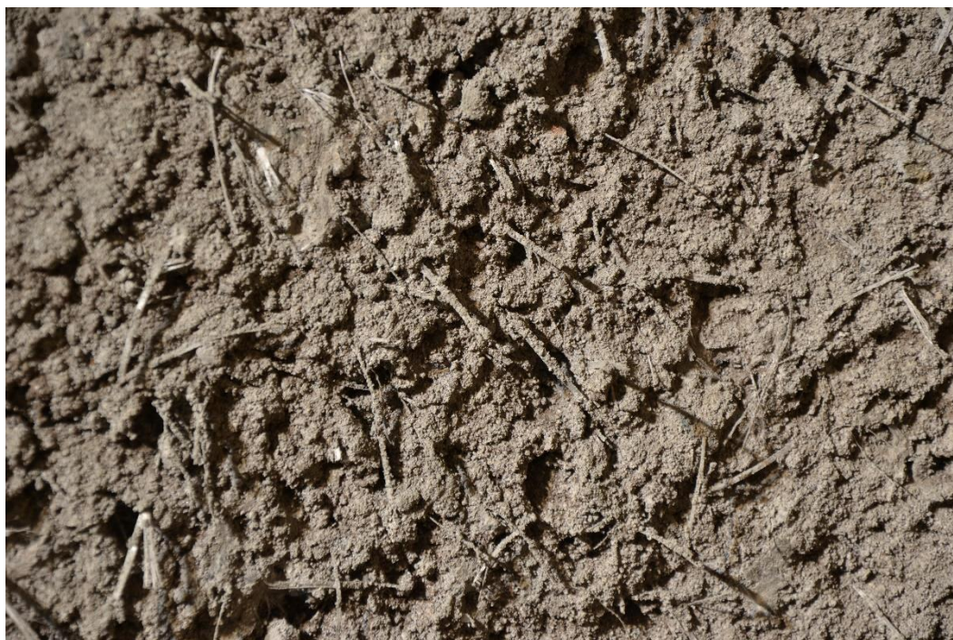
Obr. 4 Povrch definitivního ostění vyztuženého polypropylénovými makrovláknami Fig. 4 Surface of final shotcrete lining with polypropylene fibre
