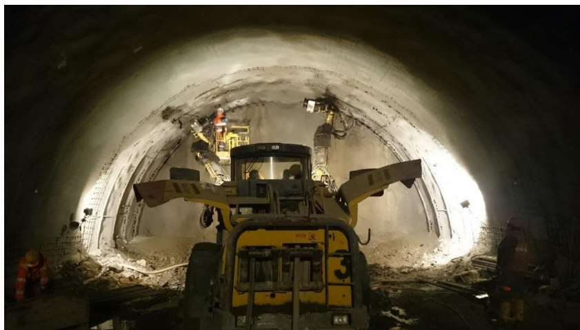
Obr. 2 Dvojlafetový vŕtací voz Atlas-Copco Boomer L2C
