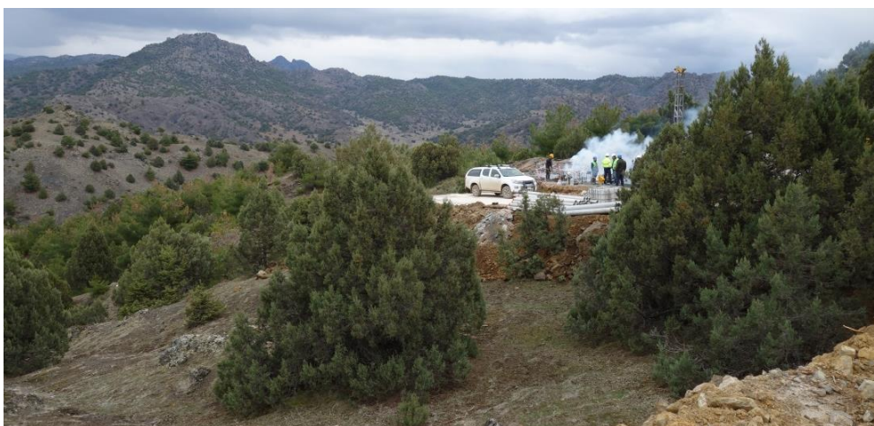
Obr. 3 Obtížně přístupný povrch nad závalem 1 pro provádění vrtů a následnou betonáž Fig. 3 Surface in mountains above the collapse 1 for drilling and concreting
