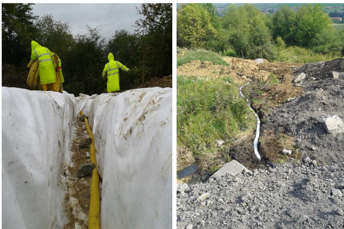
Obr. 2 Drenážny systém budovaného násypového telesa Fig. 2 Drainage system of the build embankment
