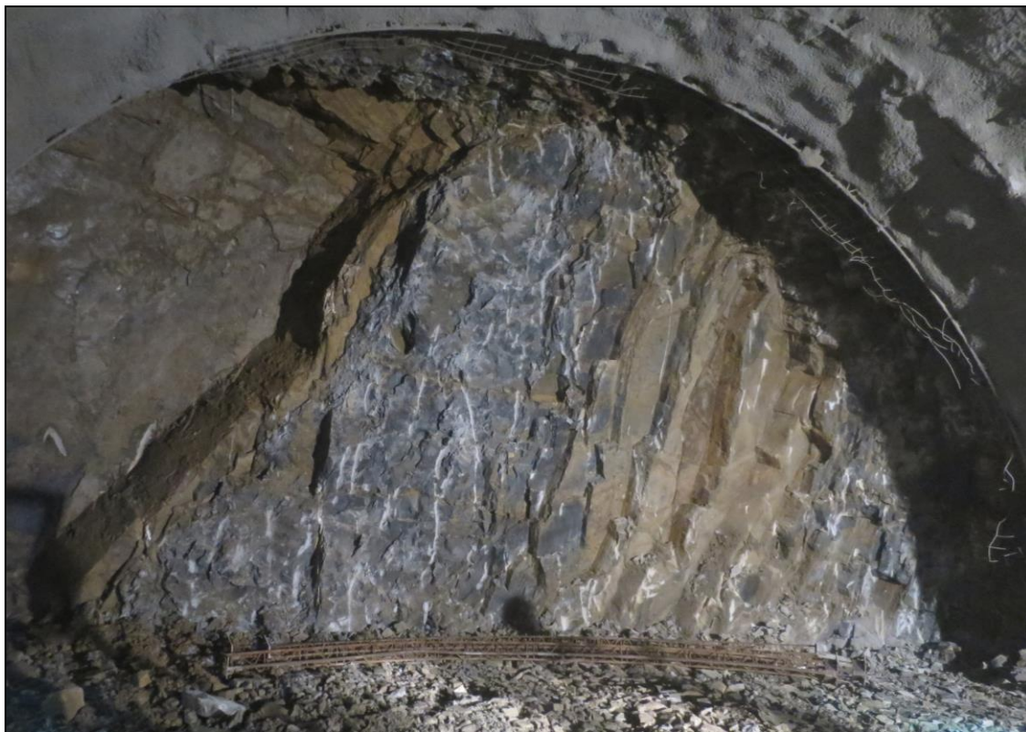
Obr. 3 Masív tvořen zvětralými a navětralými pískovci se strmým uložením jednotlivých vrstev (vystrojovací třída 5/1; TM 115,70) tunel Považský Chlmec.
