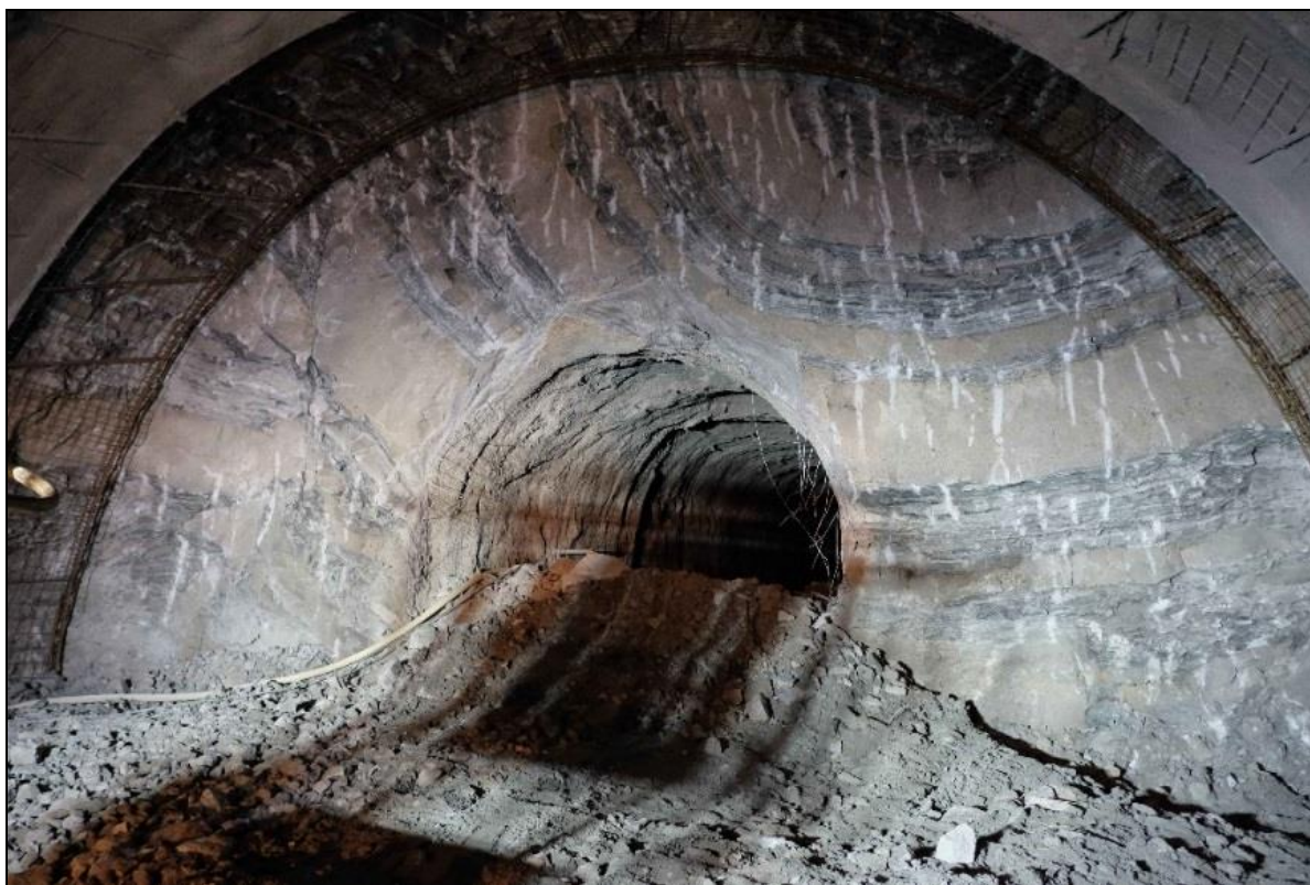
Obr. 2 Tektonicky porušené a převrásněné polohy jílovců, prachovců, pískovců a drobnozrnných polymiktních slepenců (vystrojovací třída 4/2; TM 1033,60) tunel Ovčiarsko Fig. 2 Tectonic deformed layer of claystone, sandstone and conglomerates (Excavation support class 4/2; TM 1033,60) tunnel Ovčiarsko
