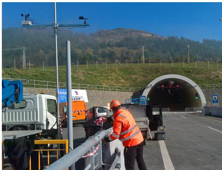
Obr. 8 Meranie na portáli tunela Považský Chlmec Fig. 8 Measurement at the portal of the tunnel Považský Chlmec
