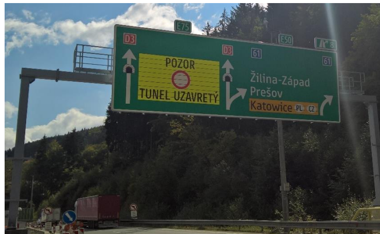
Obr. 3 Mechanické dopravné značenie so subplochami a horizontálne usporiadanými lamelami Mechanical traffic sign with subpanels and horizontal lamellas Zdroj: Fotografia, autor: Ing. Igor Jamnický
