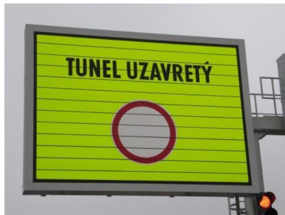
Obr. 1 Mechanické dopravné značenie s horizontálne usporiadanými lamelami Mechanical traffic sign with horizontal lamellas
