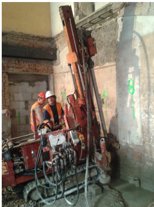
Obr. 3 Provádění tryskových injektáží v 1. PP domu Figure 3 Execution of the injection work at the 1st basement floor
