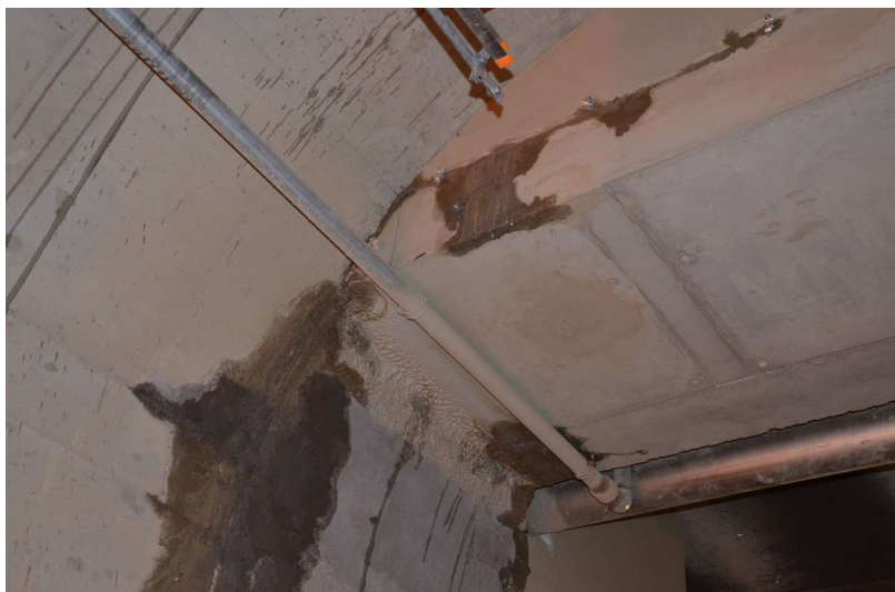
Obr. 11 Dilatační spára mezi raženou částí a stávající stanicí metra
