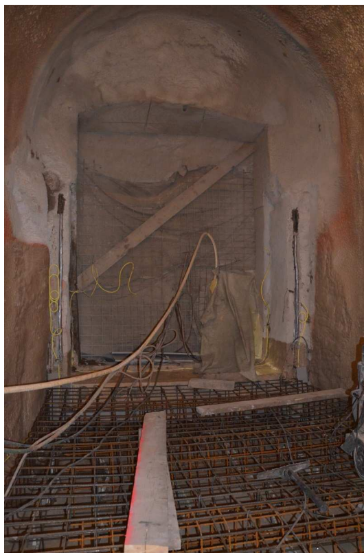
Obr. 10 armování dna CH 2 po provedení stříkaných hydroizolací (pohled na prostup do stanice metra)
